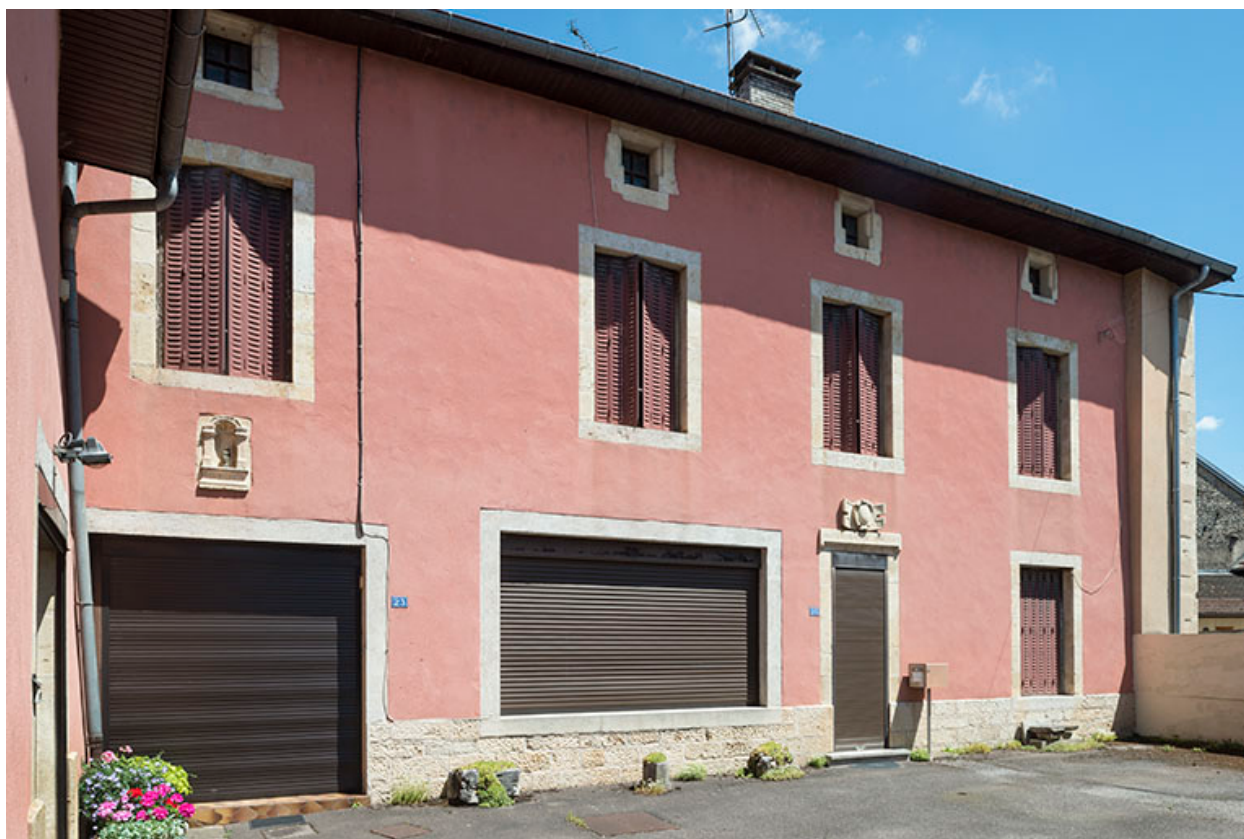
Élévation sur la cour.
