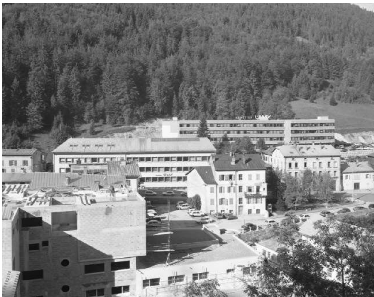
Site récent : vue d'ensemble.
