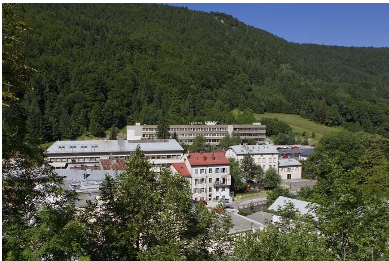
Site récent : vue d'ensemble.
