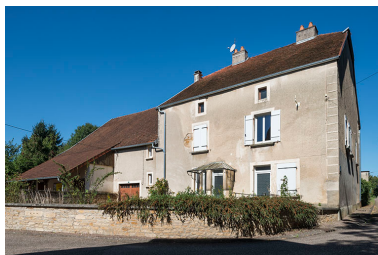
La façade antérieure. Phot. Jérôme Mongreville IVR43_20177001207NUC4A
