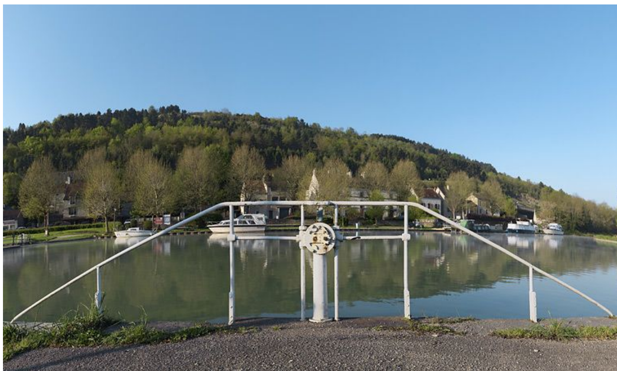
Vanne du déversoir.
