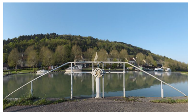
Vanne du déversoir. Phot. Thierry Kuntz IVR26_20112100067NUC4A
