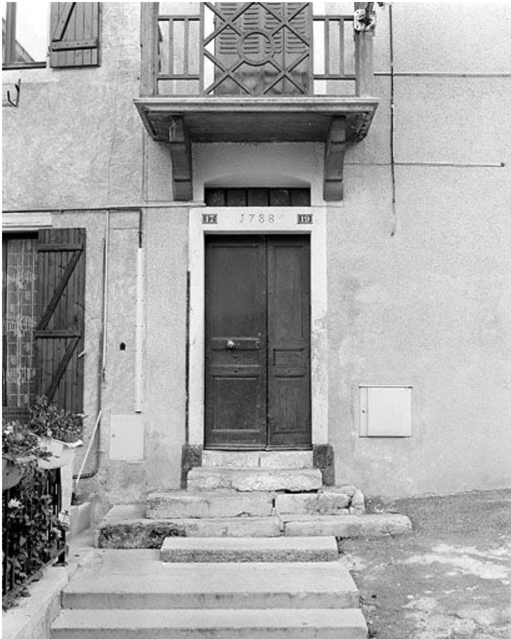
Maison avec atelier (18e siècle) aux n° 17 et 19 rue Wladimir Gagneur : porte d'entrée. Maison (AK 56, 57). L'imposte de la porte est coiffée d'un linteau délardé en arc segmentaire.
