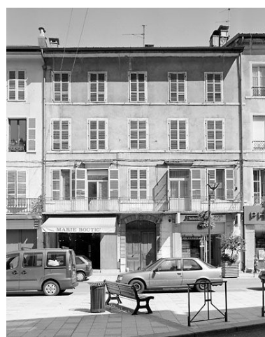
Immeuble avec atelier (19e siècle) au n° 155 rue de la République. Immeuble (AI 76) avec porte cochère et, à l'étage, un balcon filant accessible par deux portes-fenêtres, chacune surmontée d'une corniche. Phot. Yves Sancey IVR43_20033900727X
