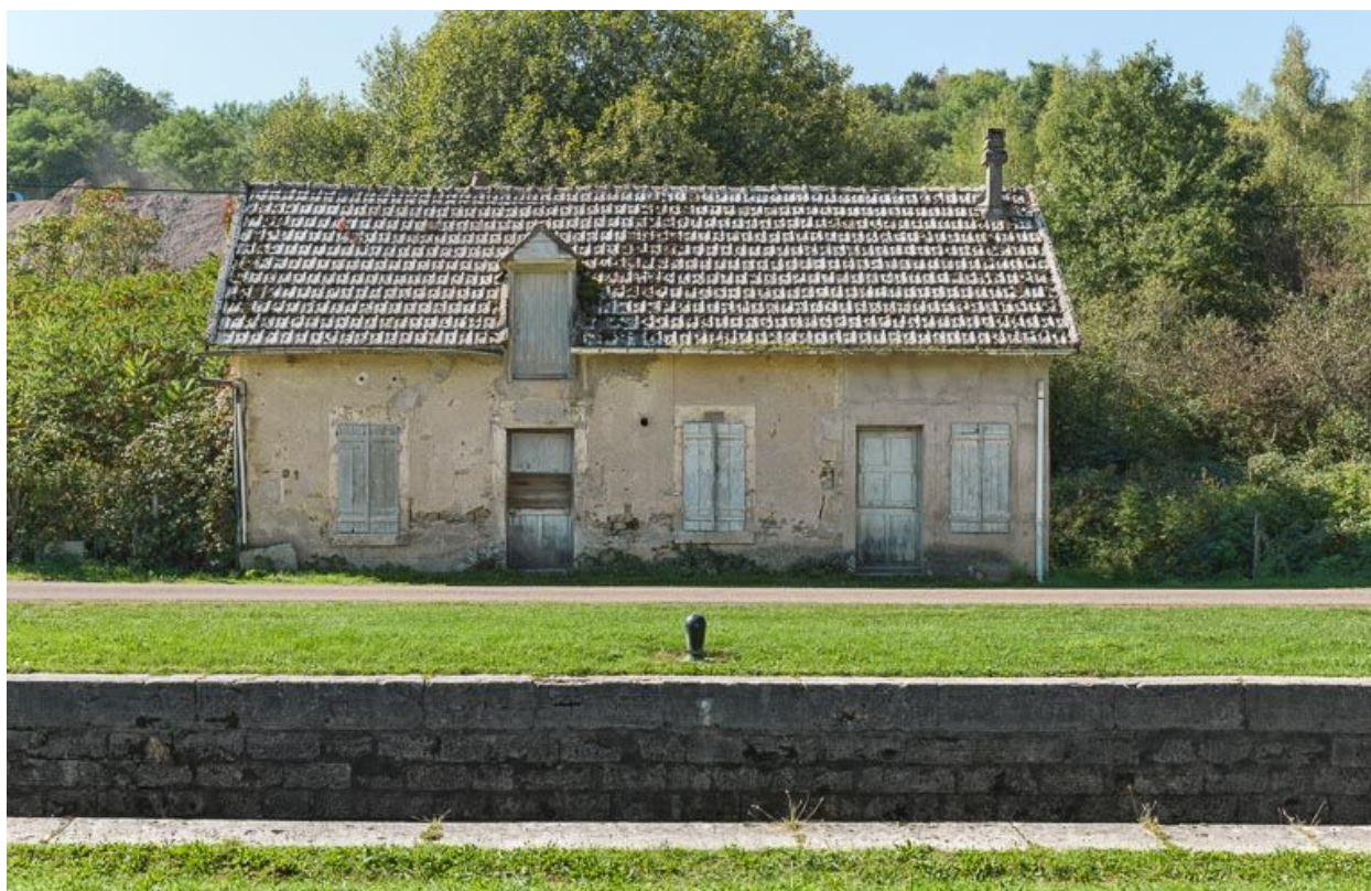
Vue de face de la maison éclusière.
