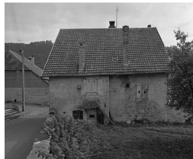
Façade postérieure. Phot. Yves Sancey IVR43_19802500857X
