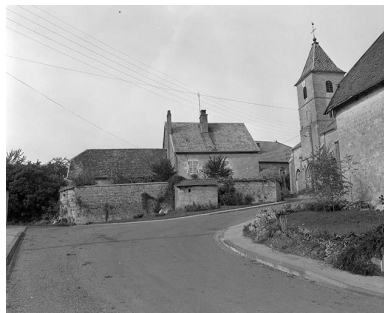
Vue générale. Phot. Yves Sancey IVR43_19802500869X
