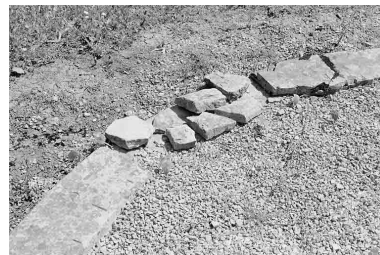
L'ellipse en pierre, avant restauration.
