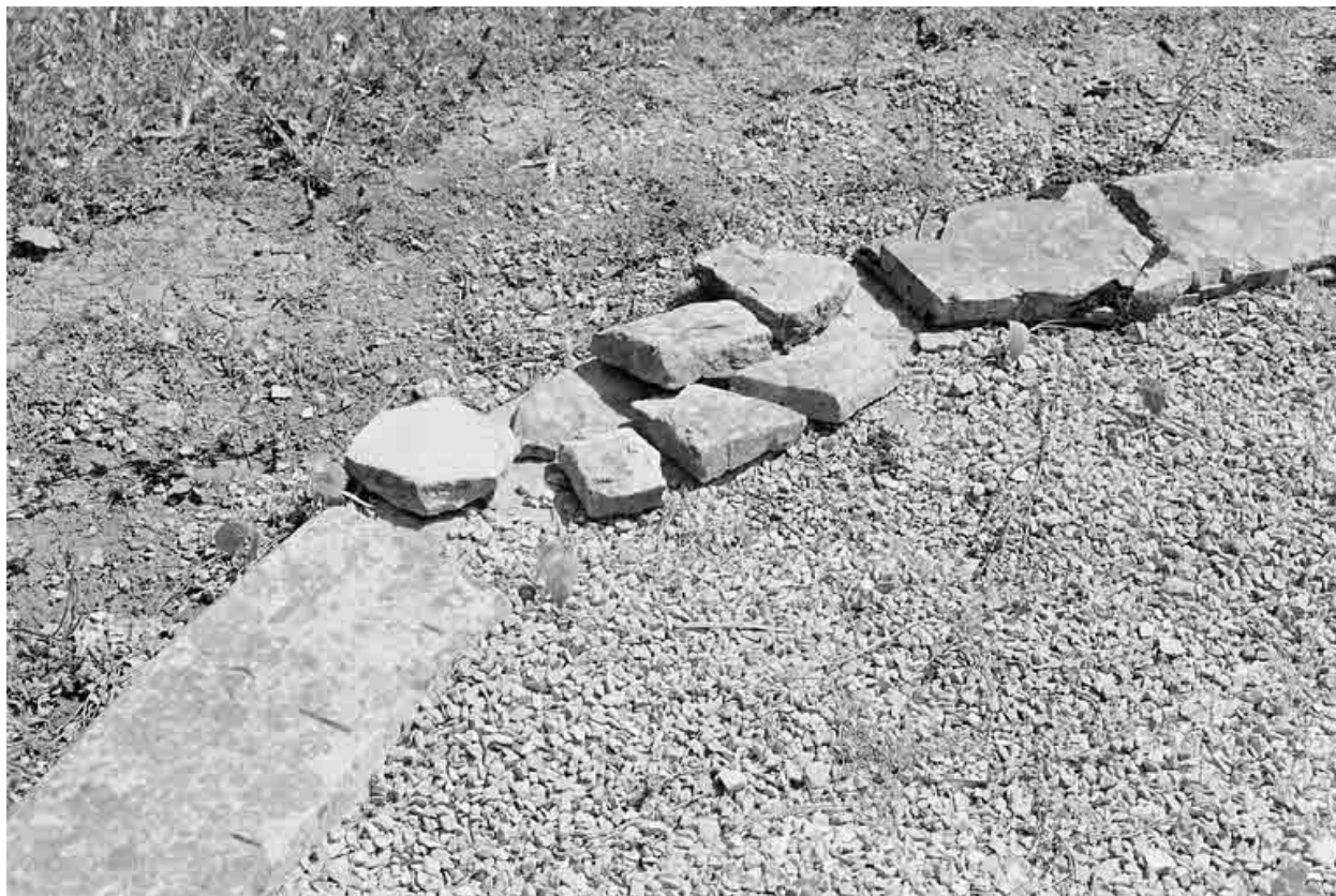
L'ellipse en pierre, avant restauration.
