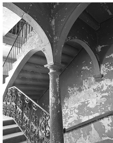
Escalier vu depuis le premier palier. Phot. Yves Sancey IVR43_19833900563X
