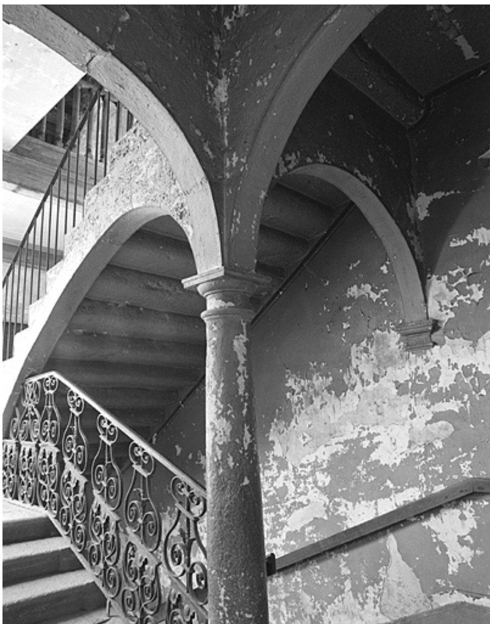
Escalier vu depuis le premier palier.
