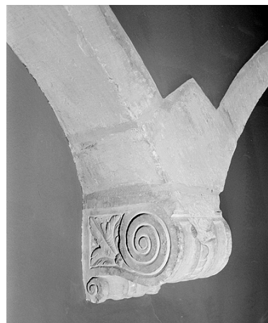
Détail du corbeau soutenant la retombée centrale de l'arc double de la pièce principale au premier étage. Phot. Jérôme Mongreville IVR43_19872500305X
