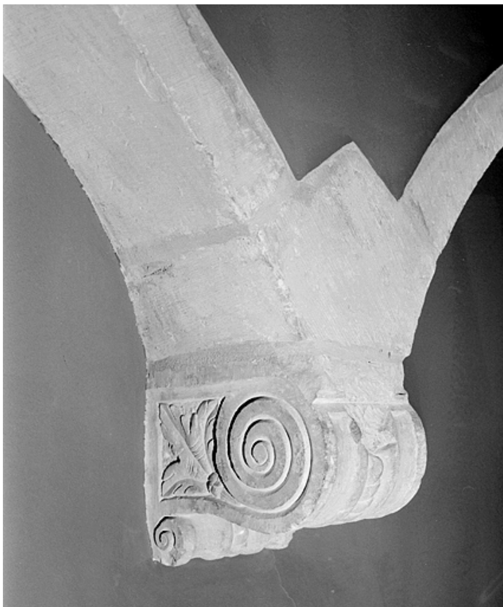
Détail du corbeau soutenant la retombée centrale de l'arc double de la pièce principale au premier étage.
