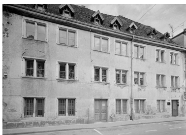
Façade principale. Phot. Jérôme Mongreville IVR43_19872501124V
