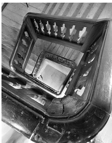
Escalier vu du deuxième étage. Phot. Jérôme Mongreville IVR43_19872500337X
