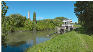
Vue d'ensemble d'aval. Phot. Thierry Kuntz IVR26_20137100276NUC4A
