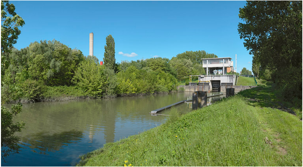
Vue d'ensemble d'aval.
