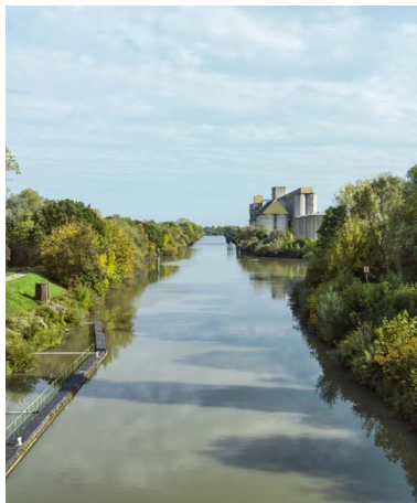
Vue du bief. Phot. Pierre-Marie Barbe-Richaud IVR26_20177100478NUC2A
