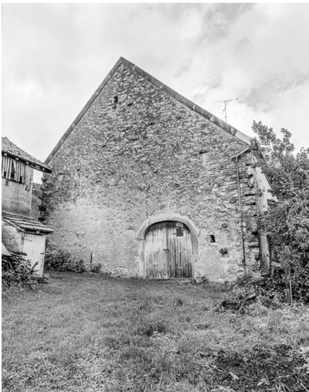
Façade latérale droite.
