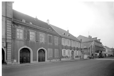
Vue d'ensemble avec la maison n° 63.
