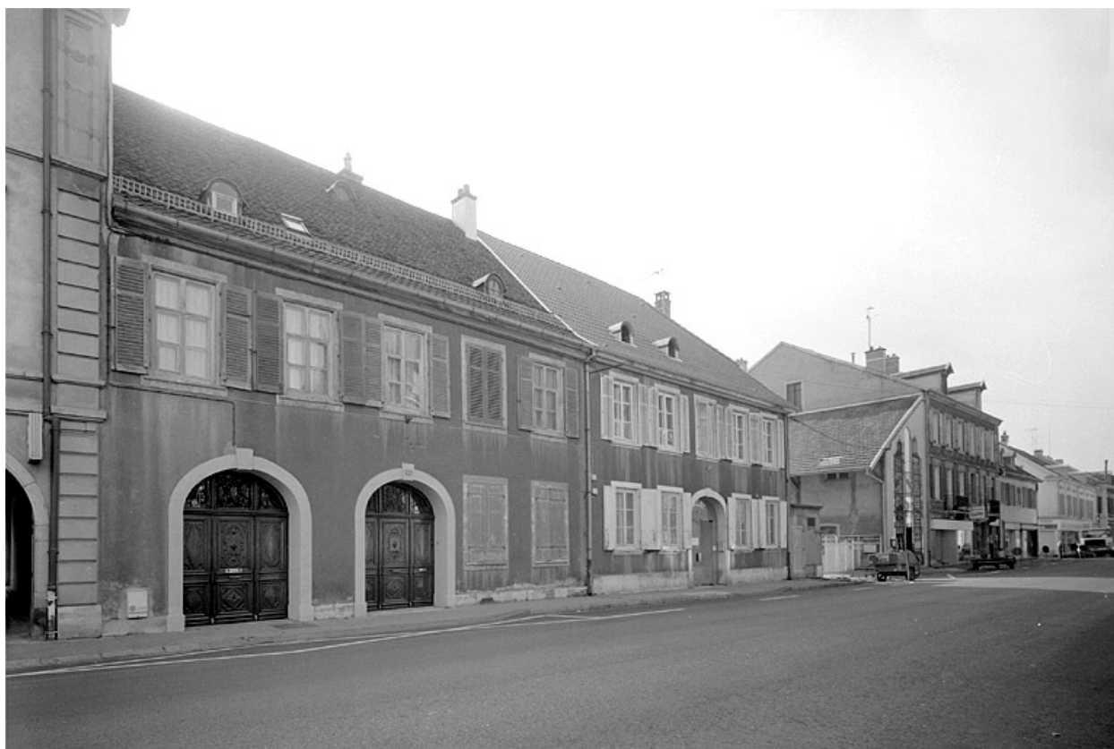
Vue d'ensemble avec la maison n° 63.
