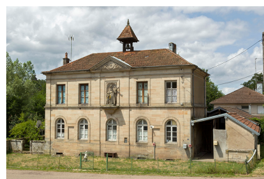
Vue d'ensemble. Phot. Sonia Dourlot IVR43_20157000652NUC2A
