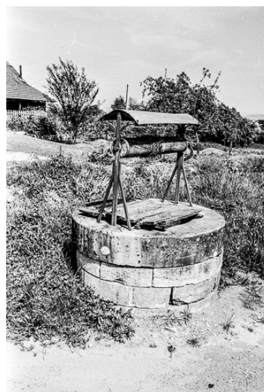
Puits : vue d'ensemble. Phot. Guy Forestier IVR43_19753900351Z
