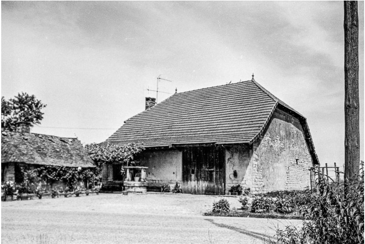
Ferme cadastrée 1963 AC : vue générale.
