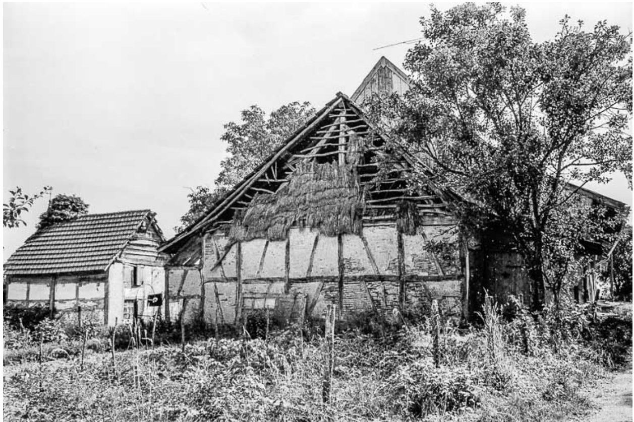
Pignon de ferme couvert en chaume.
