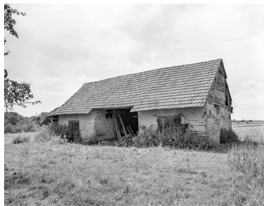
Ferme cadastrée 1963 AB 20 : façade antérieure. Phot. Dominique Dominguez IVR43_19773900070X
