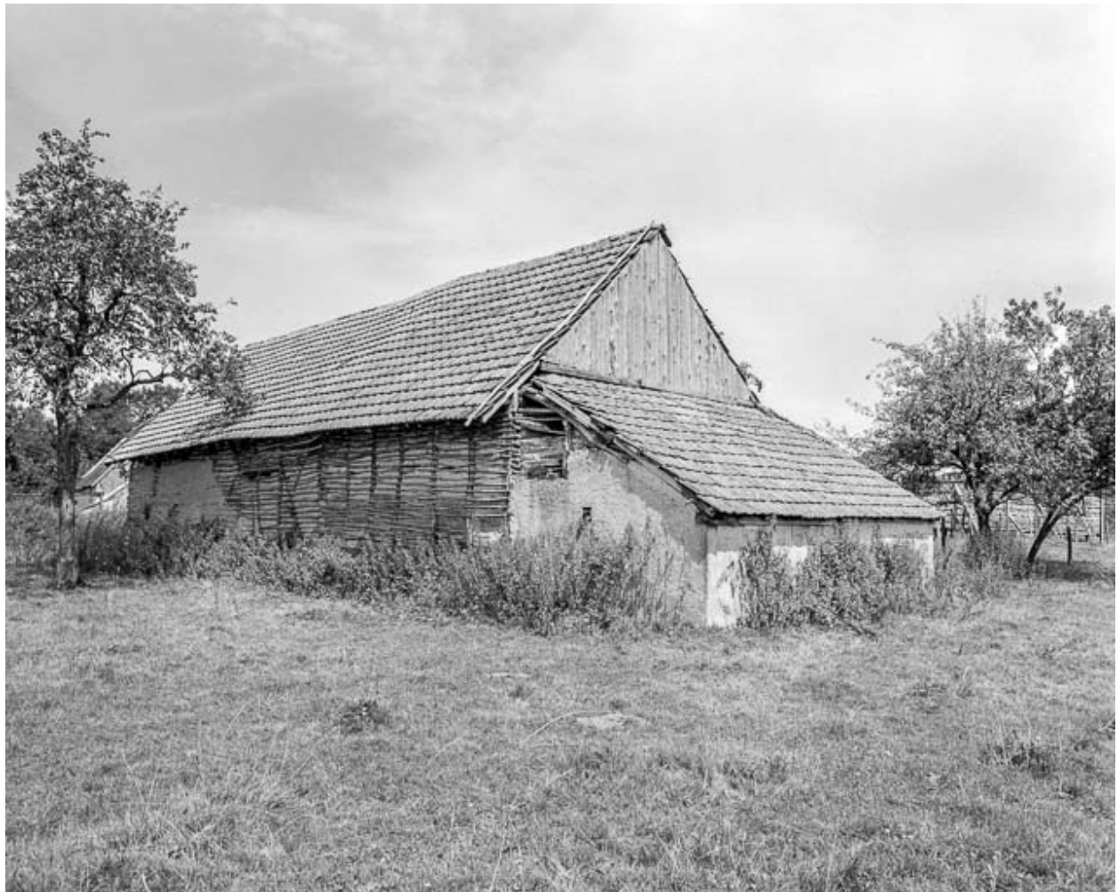
Ferme cadastrée 1963 AB 20 : façade postérieure.
