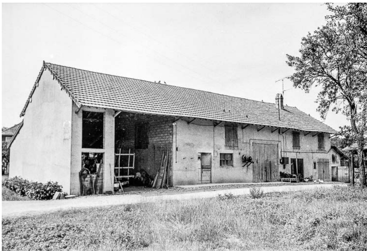
Ferme cadastrée 1963 AC : vue générale.
