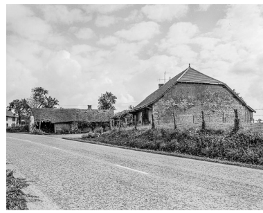
Ferme située 36 Grande Rue. Phot. Dominique Dominguez IVR43_19773900058X
