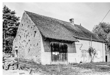
Ferme cadastrée 1963 AB 29 ou 32, située au Petit Relans : vue générale. Phot. Guy Forestier IVR43_19753900357Z
