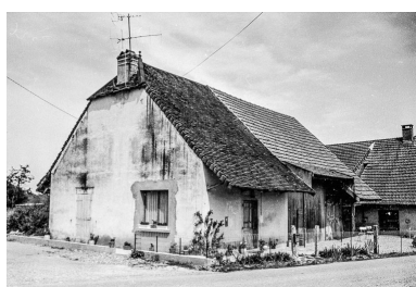
Ferme : façades et latérale droite. Phot. Guy Forestier IVR43_19753900356Z
