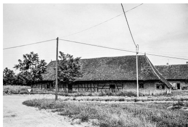
Ferme cadastrée 1963 AC : façade postérieure. Phot. Guy Forestier IVR43_19753900347Z
