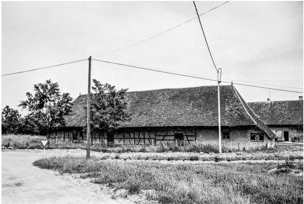
Ferme cadastrée 1963 AC : façade postérieure.
