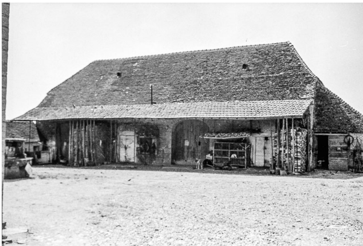
Ferme cadastrée 1963 AB 29 ou 32, située au Petit Relans : vue générale.
