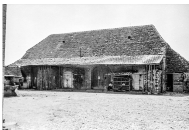
Ferme cadastrée 1963 AB 29 ou 32, située au Petit Relans : vue générale. Phot. Guy Forestier IVR43_19753900358Z
