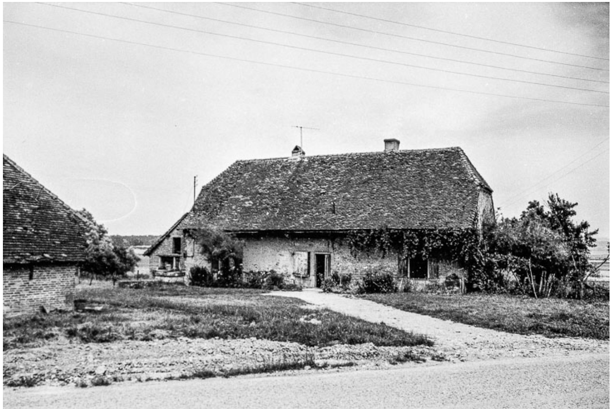
Ferme cadastrée 1963 AC : façade antérieure.
