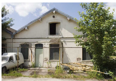
Bâtiment des bureaux (?). Phot. Jérôme Mongreville IVR43_20097000445NUC2A
