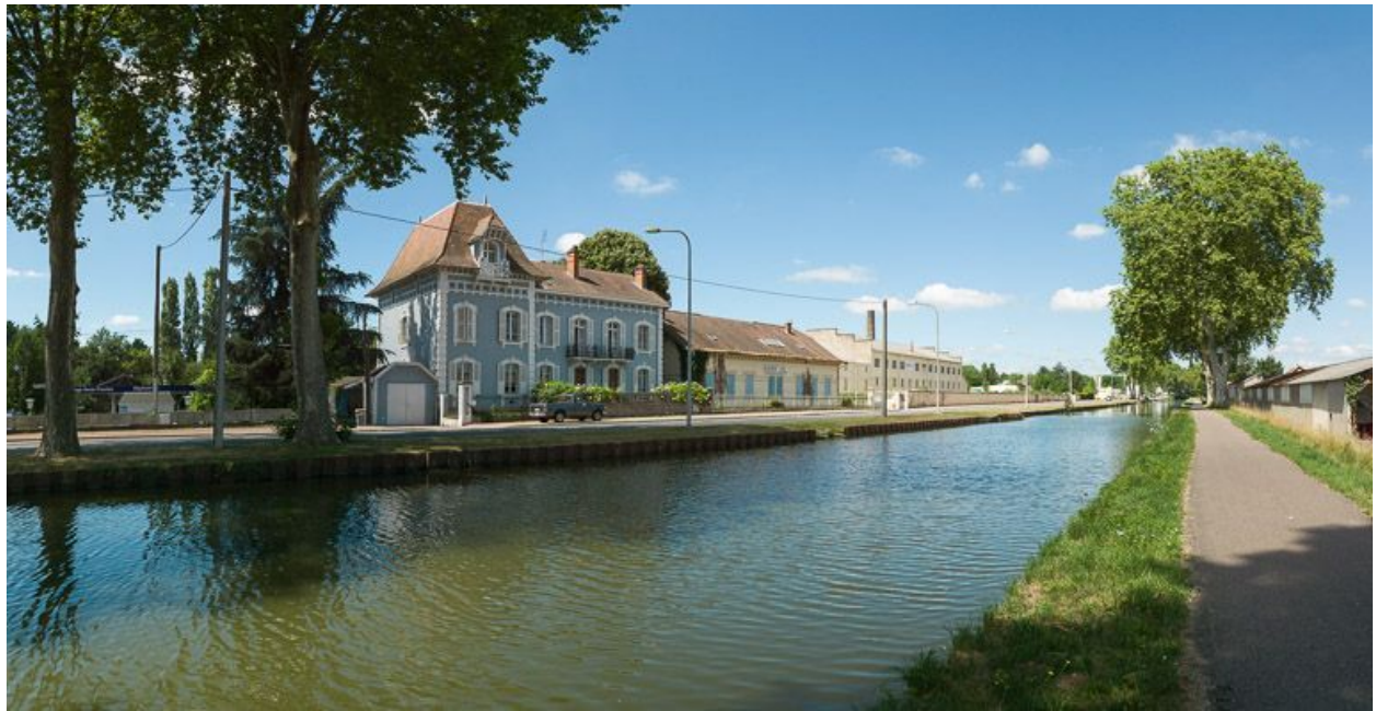
Les bâtiments de l'usine, rive gauche.
