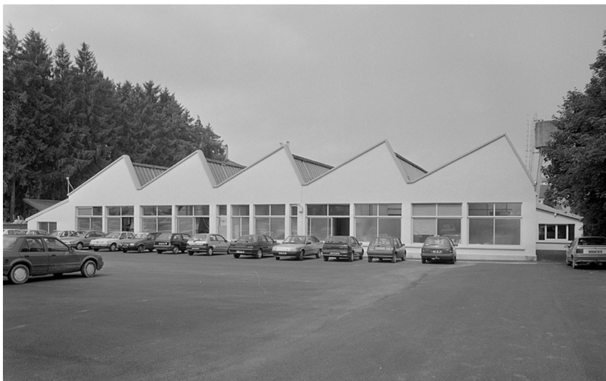
Atelier de fabrication depuis l'est.
