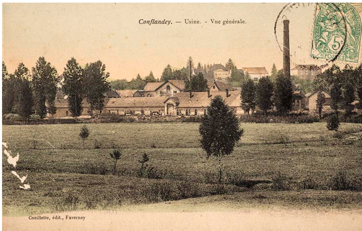
Vue générale de l'usine, Conflandey.
