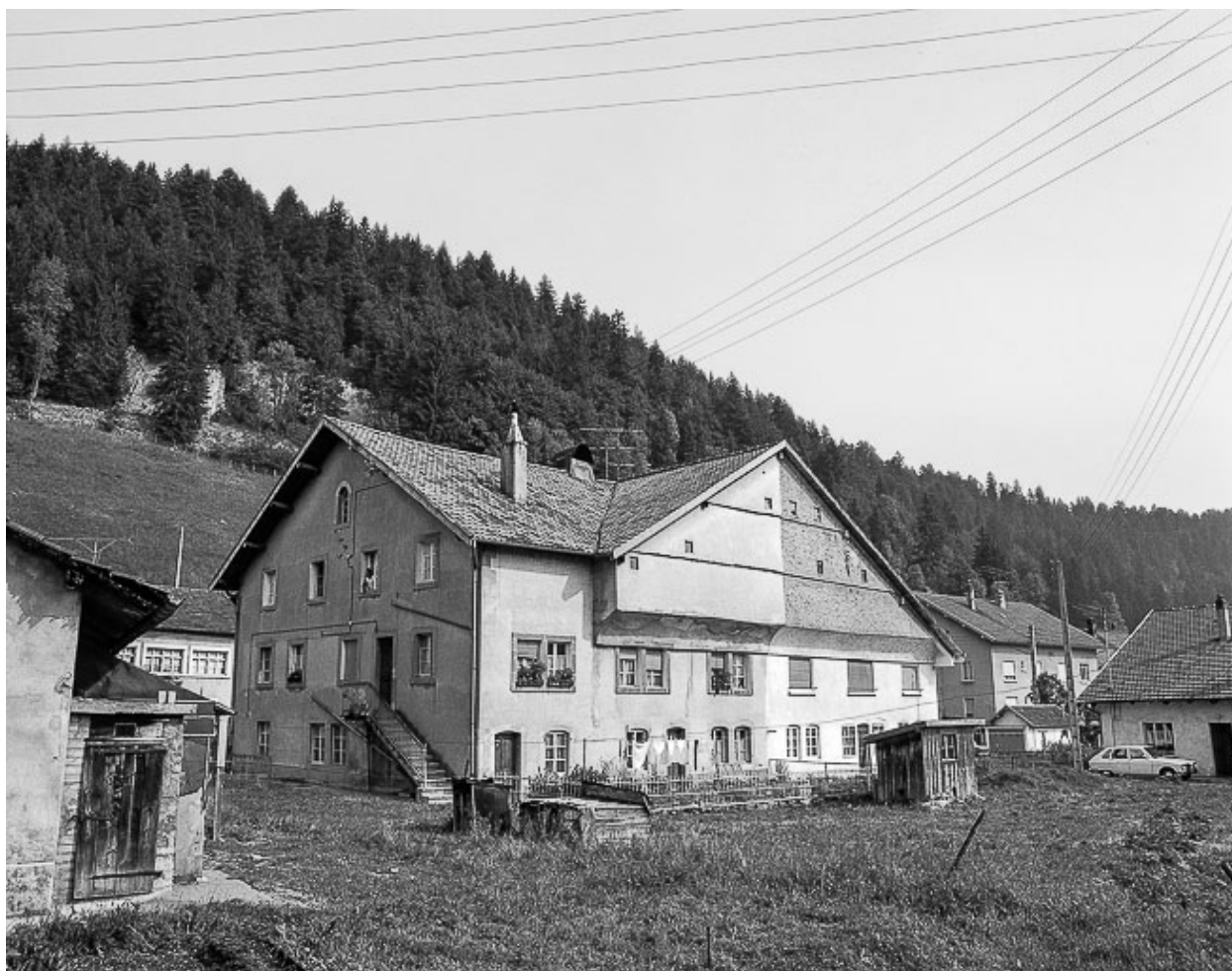
Façades postérieure et latérale droite, en 1976.
