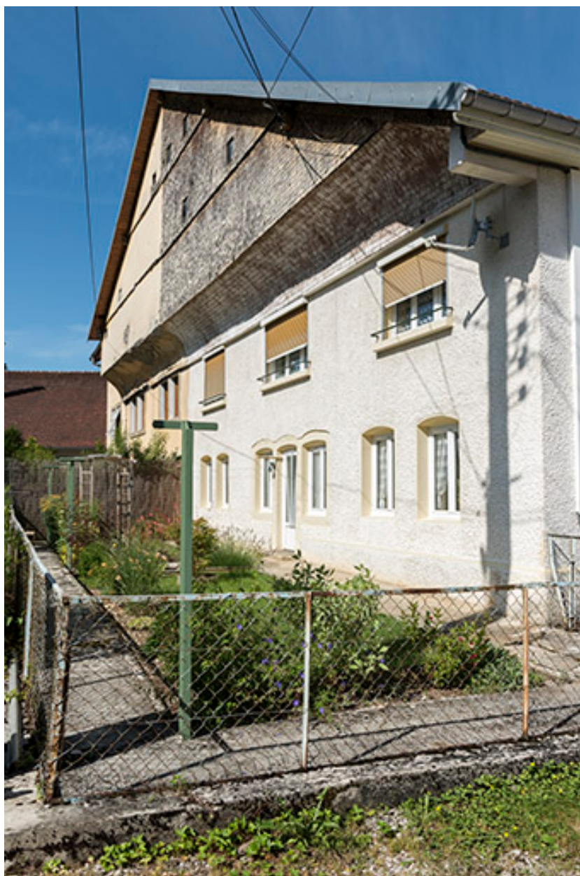
Façade postérieure, vue en enfilade.
