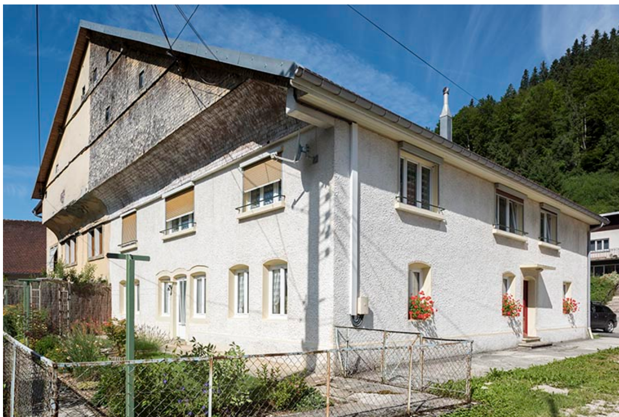
Façades postérieure et latérale gauche.
