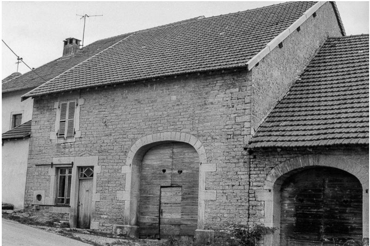
Ferme cadastrée B2 124 (droite) : façade antérieure.
