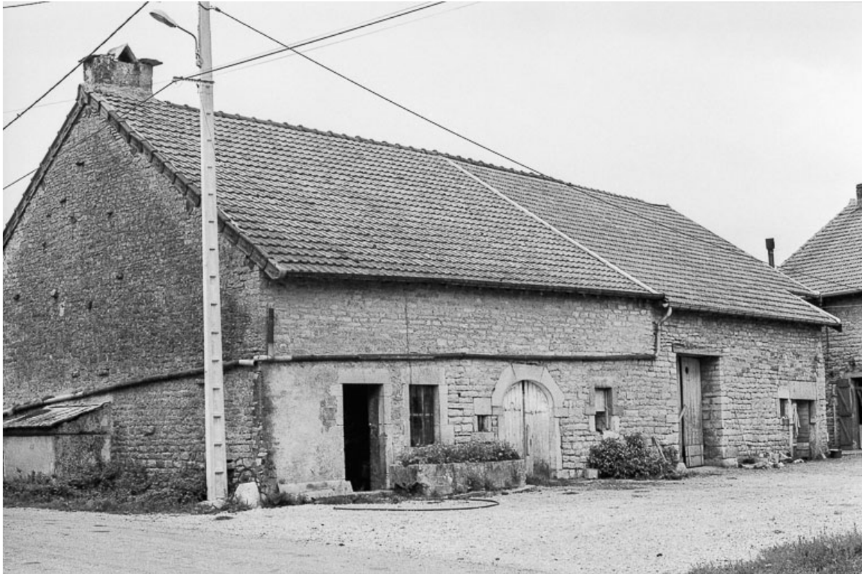
Ferme cadastrée B2 157 : façade sur rue.
