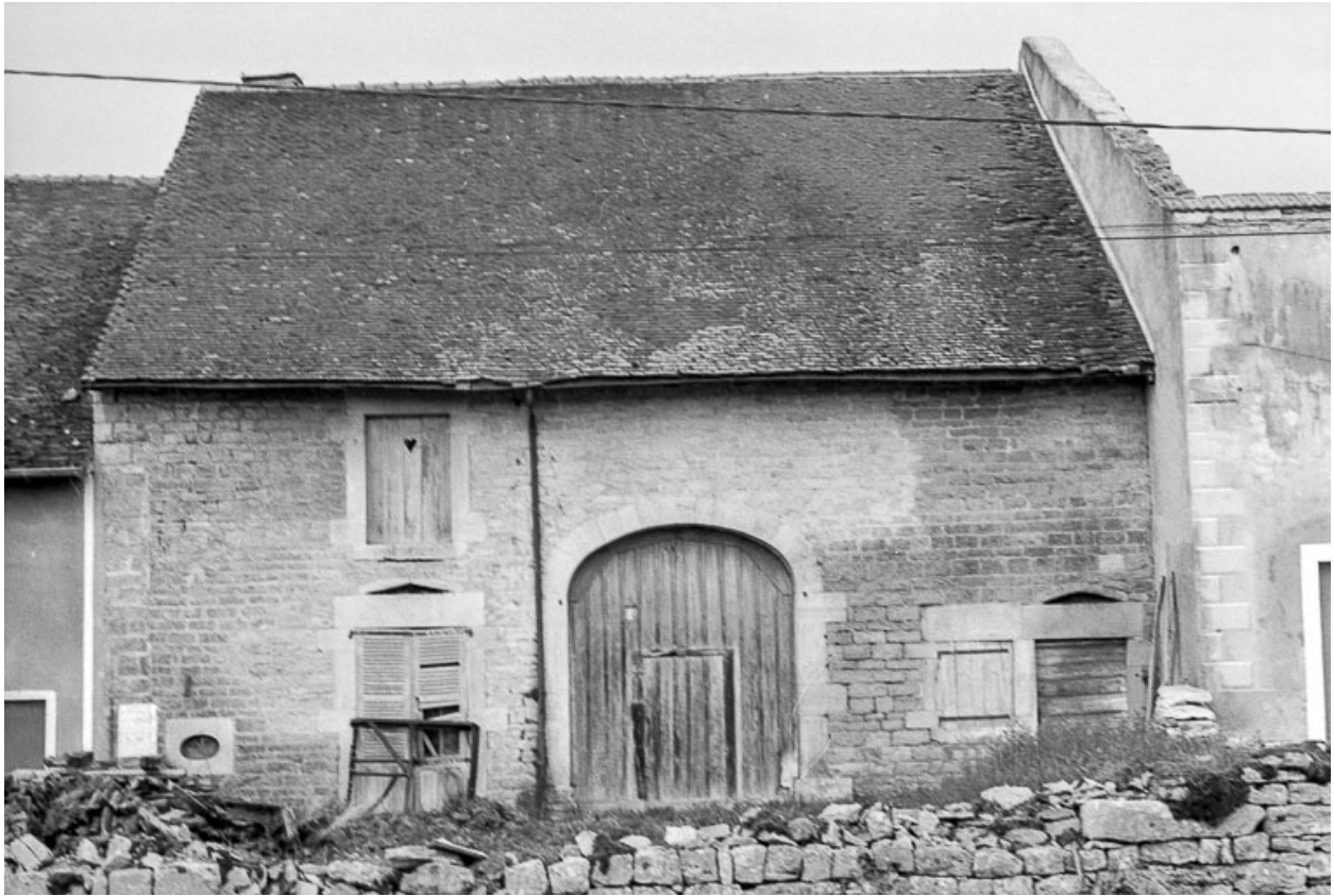
Ferme cadastrée B2 134 : façade postérieure (?).
