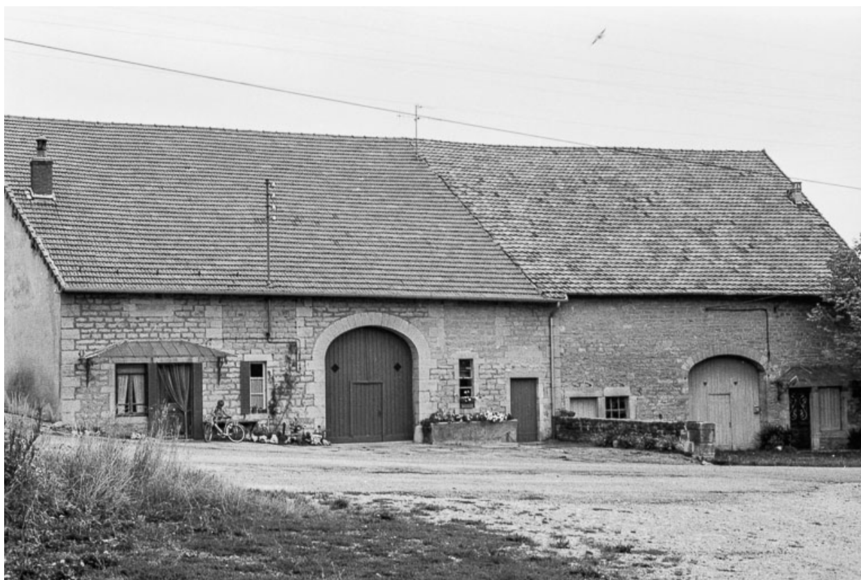
Ferme cadastrée B2 181 et 182 : façades antérieures.
