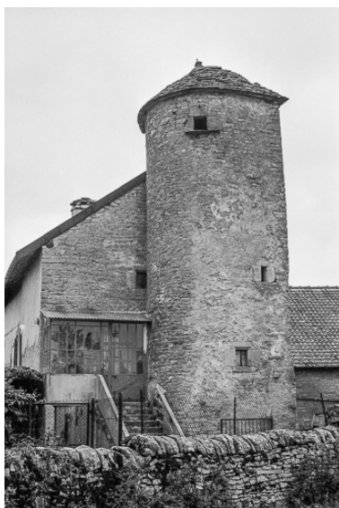
Ferme : tour et mur en pierre sèche. Phot. Bernard Pontefract IVR43_19763900226Z
