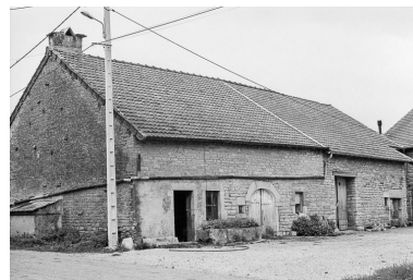
Ferme cadastrée B2 157 : façade sur rue. Phot. Bernard Pontefract IVR43_19763900227Z
