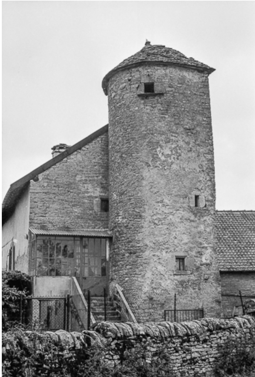
Ferme : tour et mur en pierre sèche.
