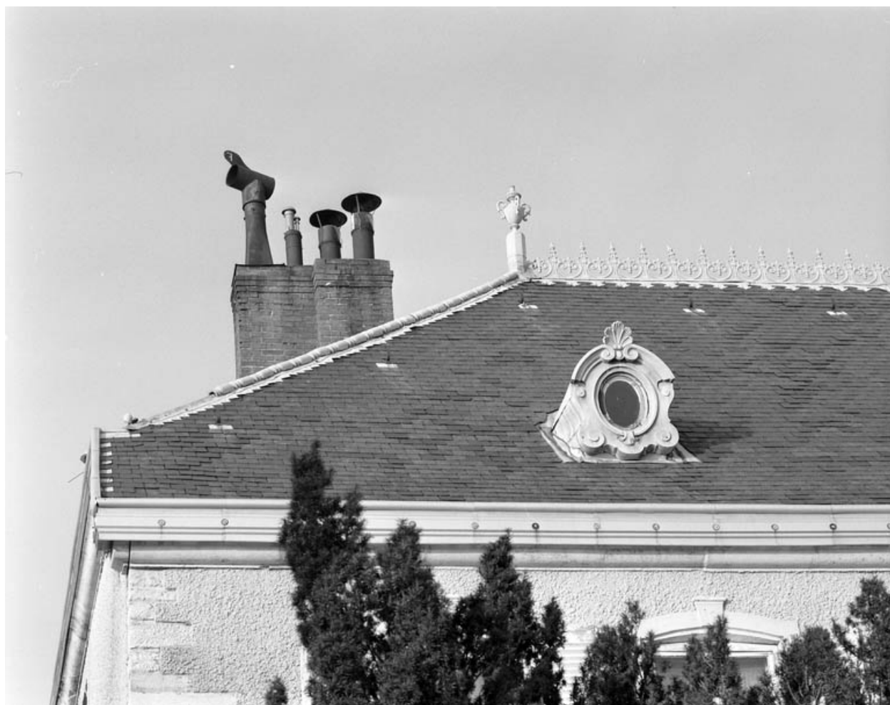
Détail d'une lucarne du toit de l'habitation.
