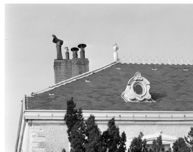
Détail d'une lucarne du toit de l'habitation. Phot. Yves Sancey IVR43_19947000032X
