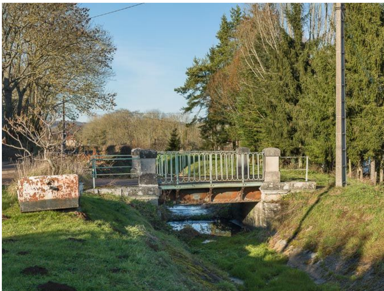
Vue d'ensemble du pont.
