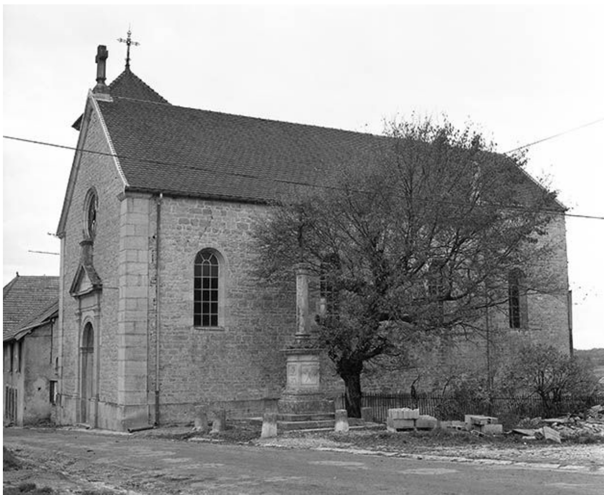
Façade antérieure et face latérale droite.
