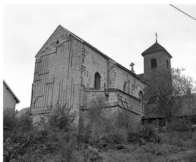
Le chevet et la face latérale gauche. Phot. Yves Sancey IVR43_19762501109X
