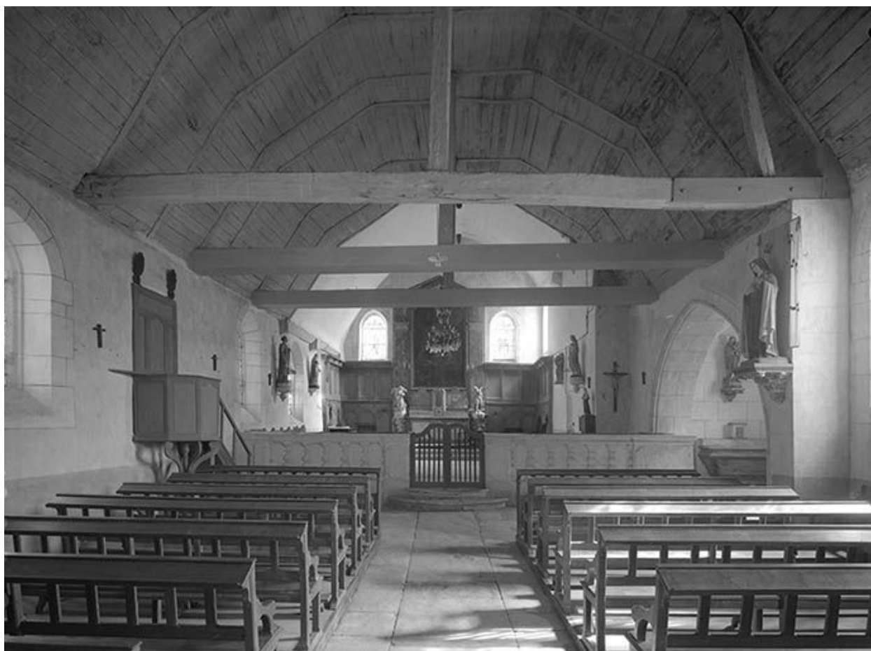
Nef et chœur, vue de l'entrée.
