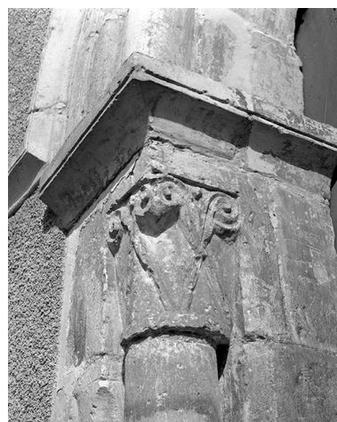
Portail : chapiteau gauche. IVR26_19728900368X
