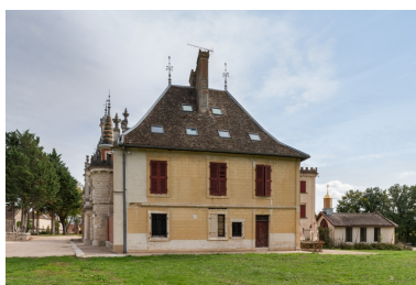
Elévation postérieure (ouest). Phot. Pierre-Marie Barbe-Richaud IVR26_20222100900NUC4A
