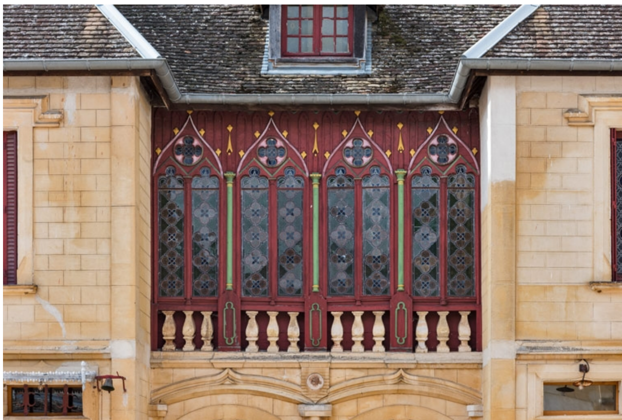
Elévation antérieure : galerie à l'étage.
