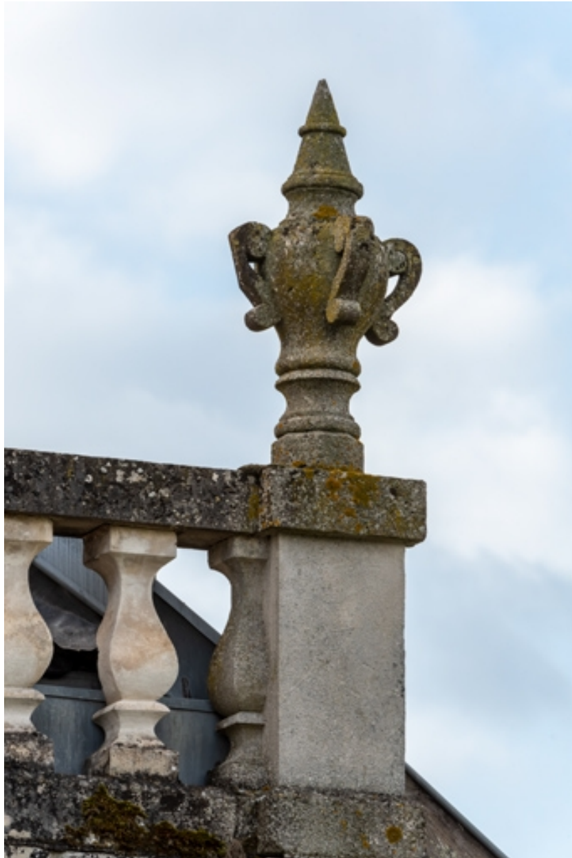
Elévation latérale droite : motif d'amortissement.
