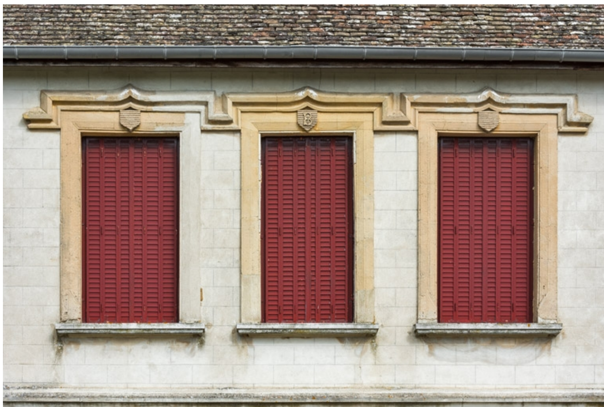
Elévation latérale gauche : baies de l'étage.
