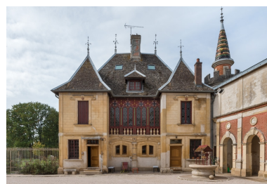
Elévation antérieure (est). Phot. Pierre-Marie Barbe-Richaud IVR26_20222100914NUC4A
