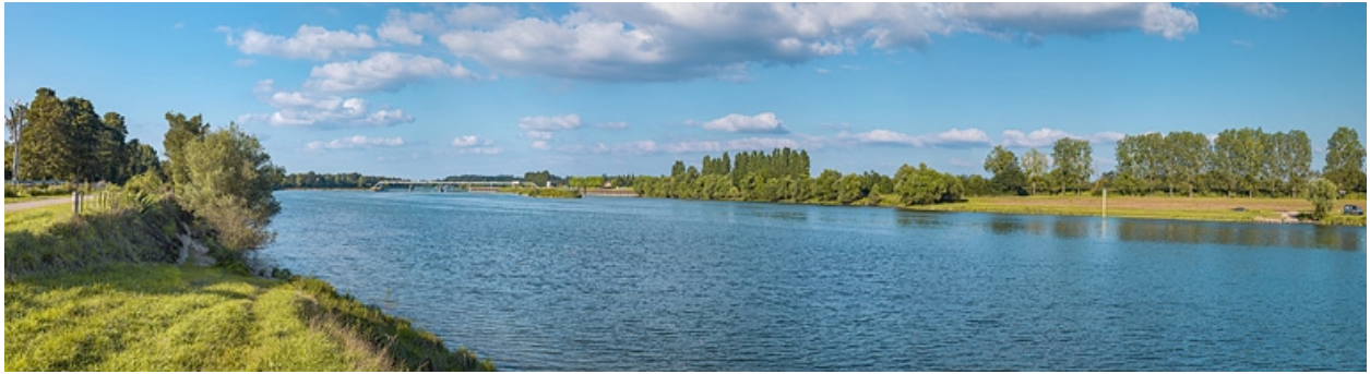
L'aval du barrage d'Ormes depuis la Mare-Jandeau.
