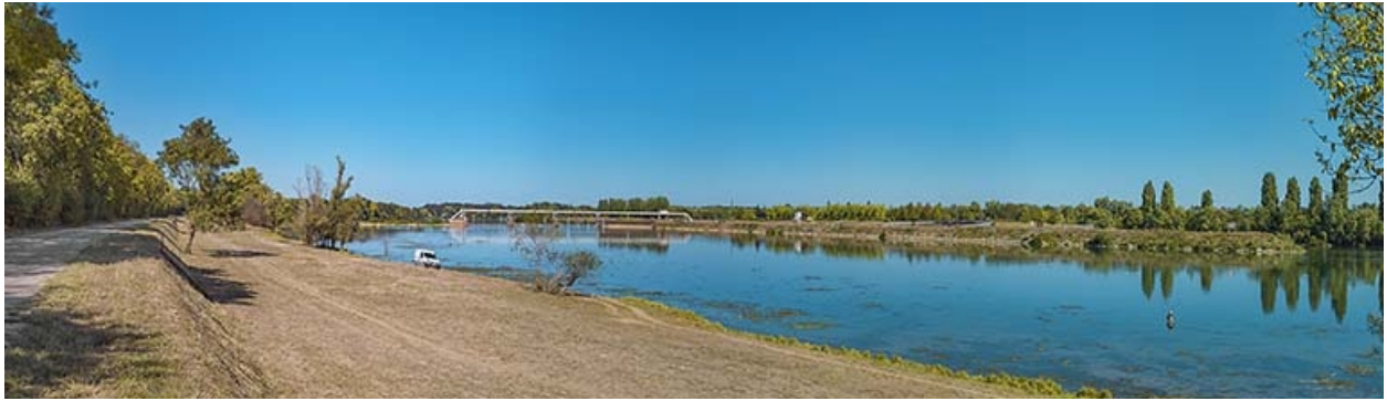
Les perrés et le barrage d'Ormes.
