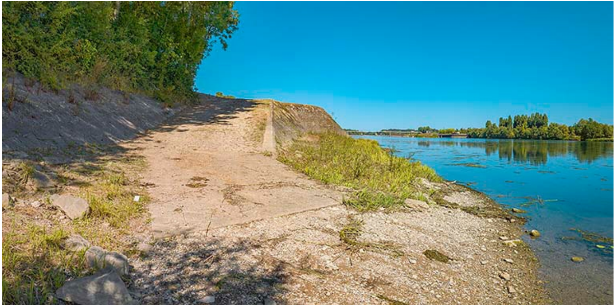
Rampe et perrés de la Mare-Jandeau.
