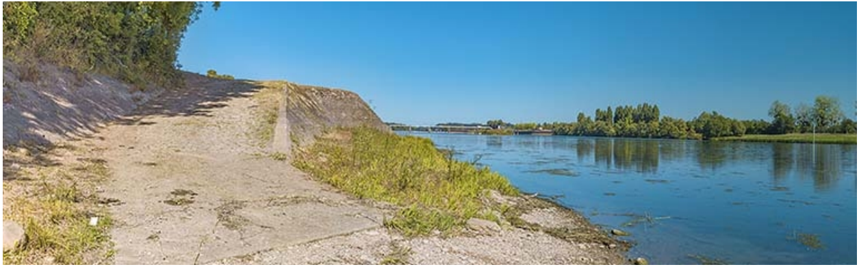
Rampe et perrés de la Mare-Jandeau.
