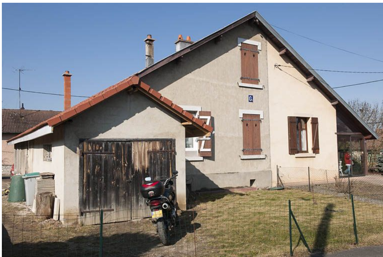
Façade ouest d'une maison jumelée.
