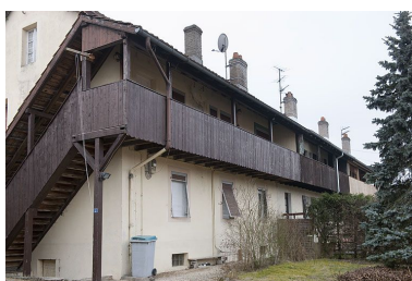
Immeuble (12 logements ?). Façade postérieure. Phot. Jérôme Mongreville IVR43_20122500187NUC4A
