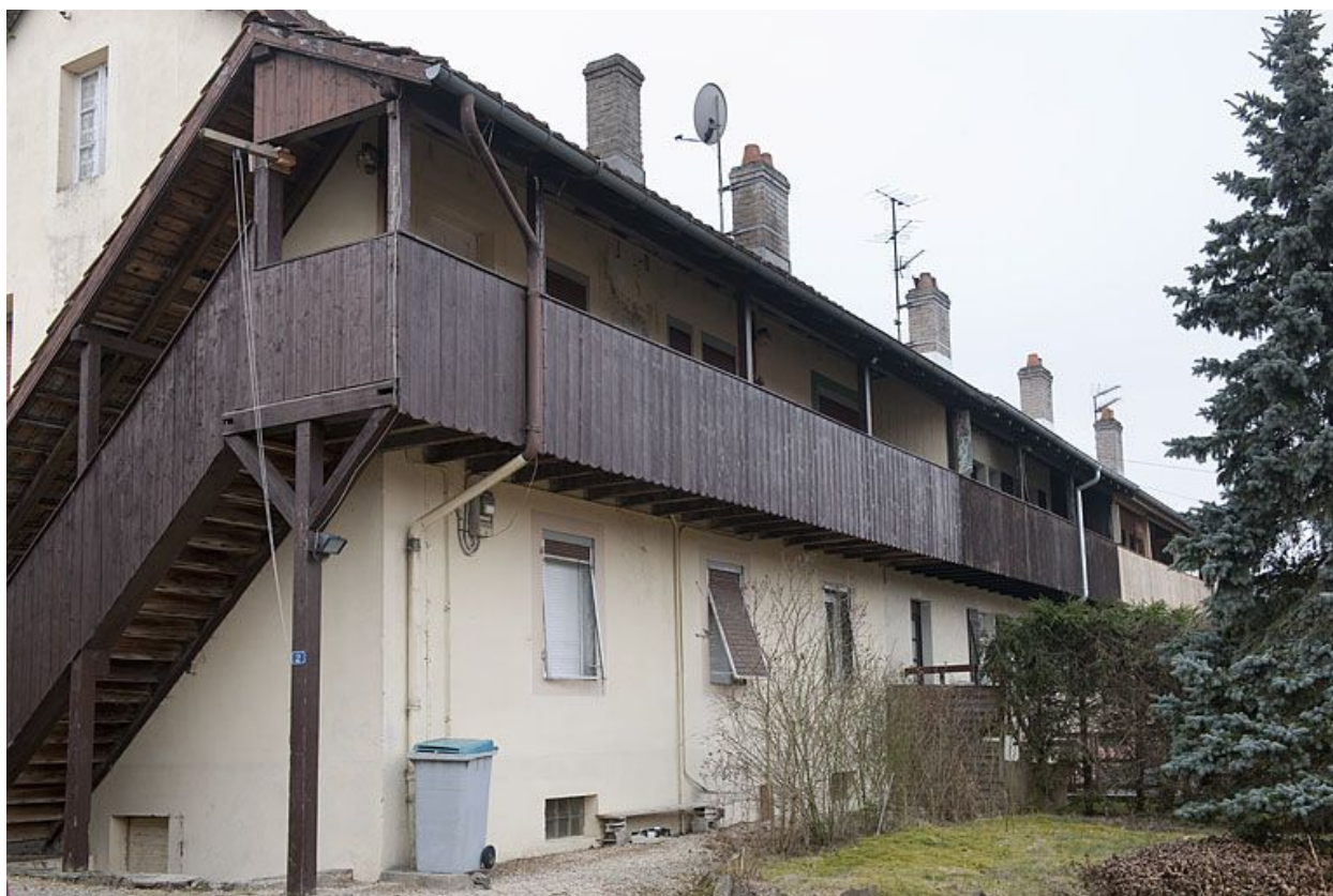
Immeuble (12 logements ?). Façade postérieure.
