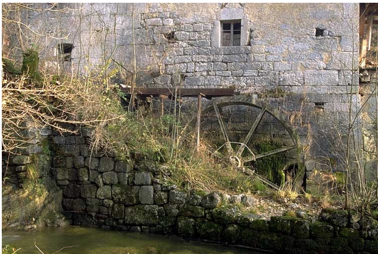
Roue hydraulique verticale aval.
