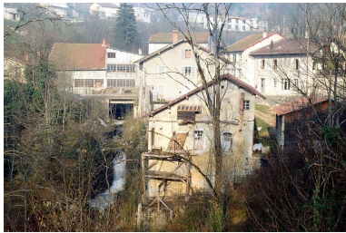
Vue d'ensemble depuis l'aval. Phot. Laurent Poupard IVR43_19913901253ZA
