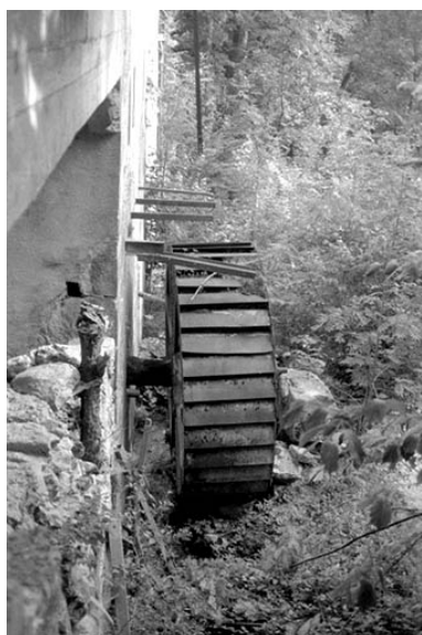
Roue hydraulique verticale amont. Phot. Laurent Poupard IVR43_19913901263Z
