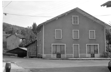
Façade antérieure du logement. Phot. Laurent Poupard IVR43_19913901257Z
