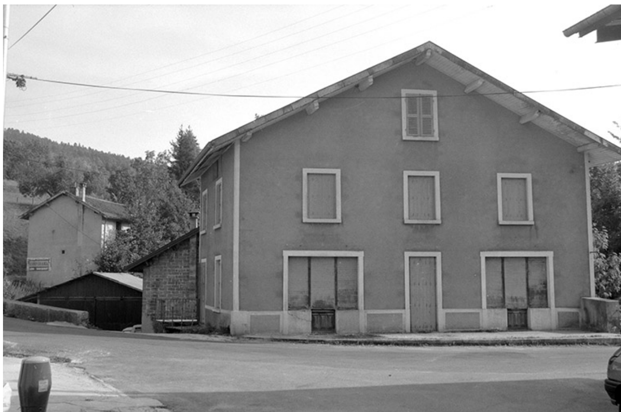
Façade antérieure du logement.
