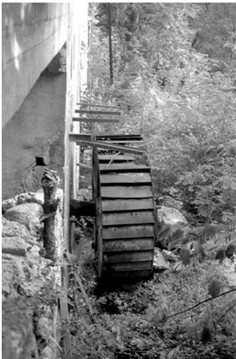
Roue hydraulique verticale amont.
