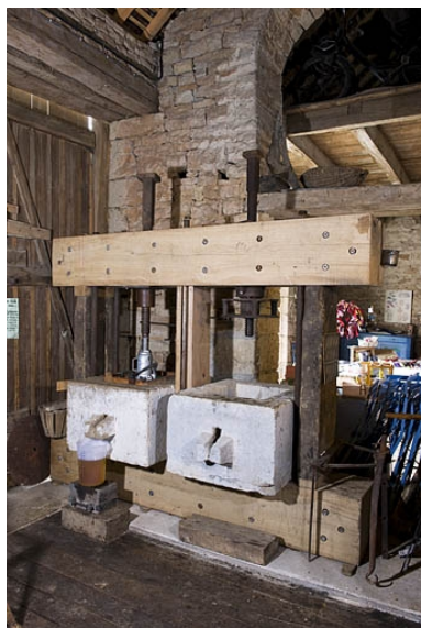
Couple de presseoirs installé début 2010. Phot. Jérôme Mongreville IVR43_20107000008NUC4A
