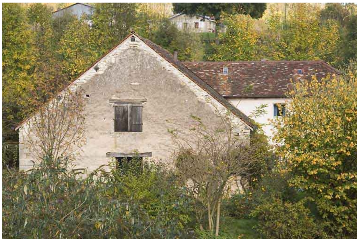
Pignon sud du moulin.
