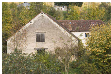
Pignon sud du moulin. Phot. Jérôme Mongreville IVR43_20087000971NUC2A
