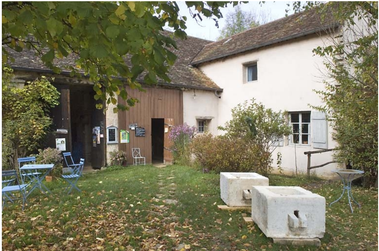
Façade est du moulin et logement.
