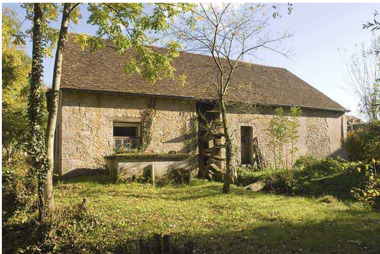
Façade postérieure du moulin.
