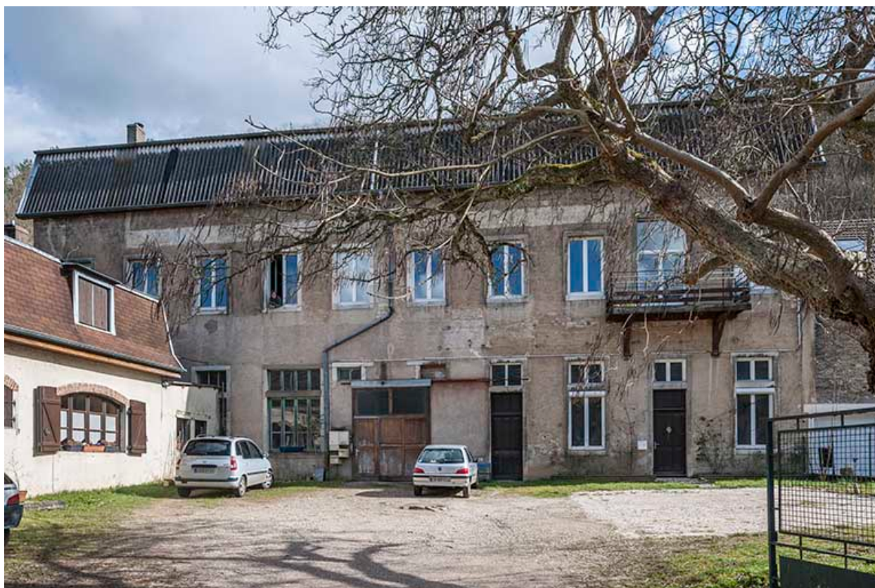
Façade antérieure de l'atelier de fabrication.
