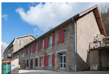
Logements ouvriers, vus de trois quarts droite. Phot. Jérôme Mongreville
