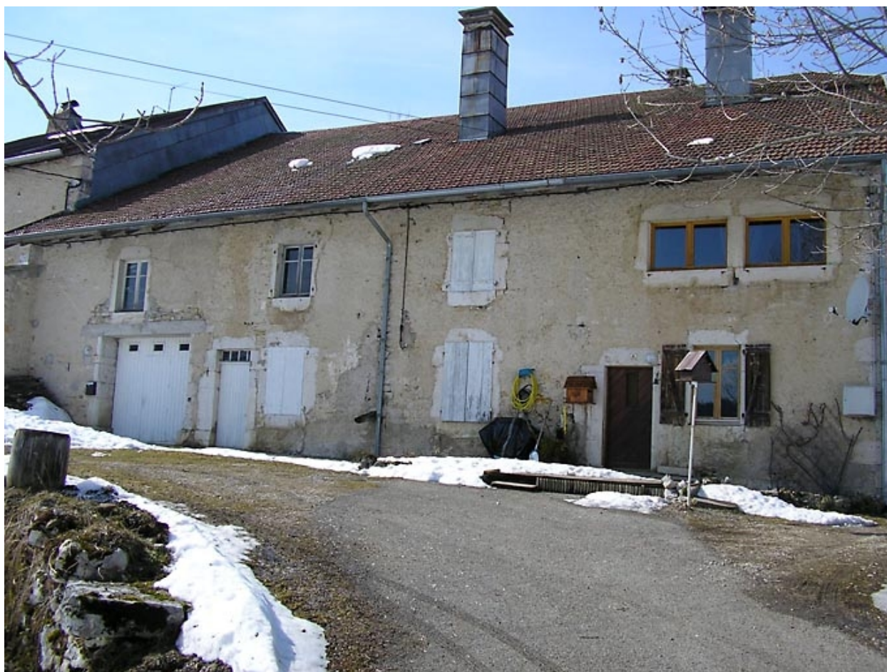
Ferme située au lieu-dit Les Jeannez.
