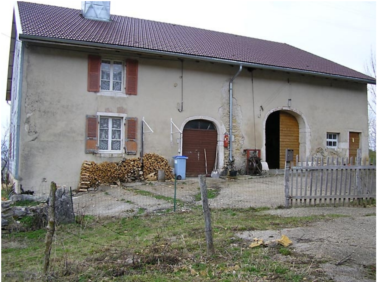
Ferme située au lieu-dit Sur le Moulin.
