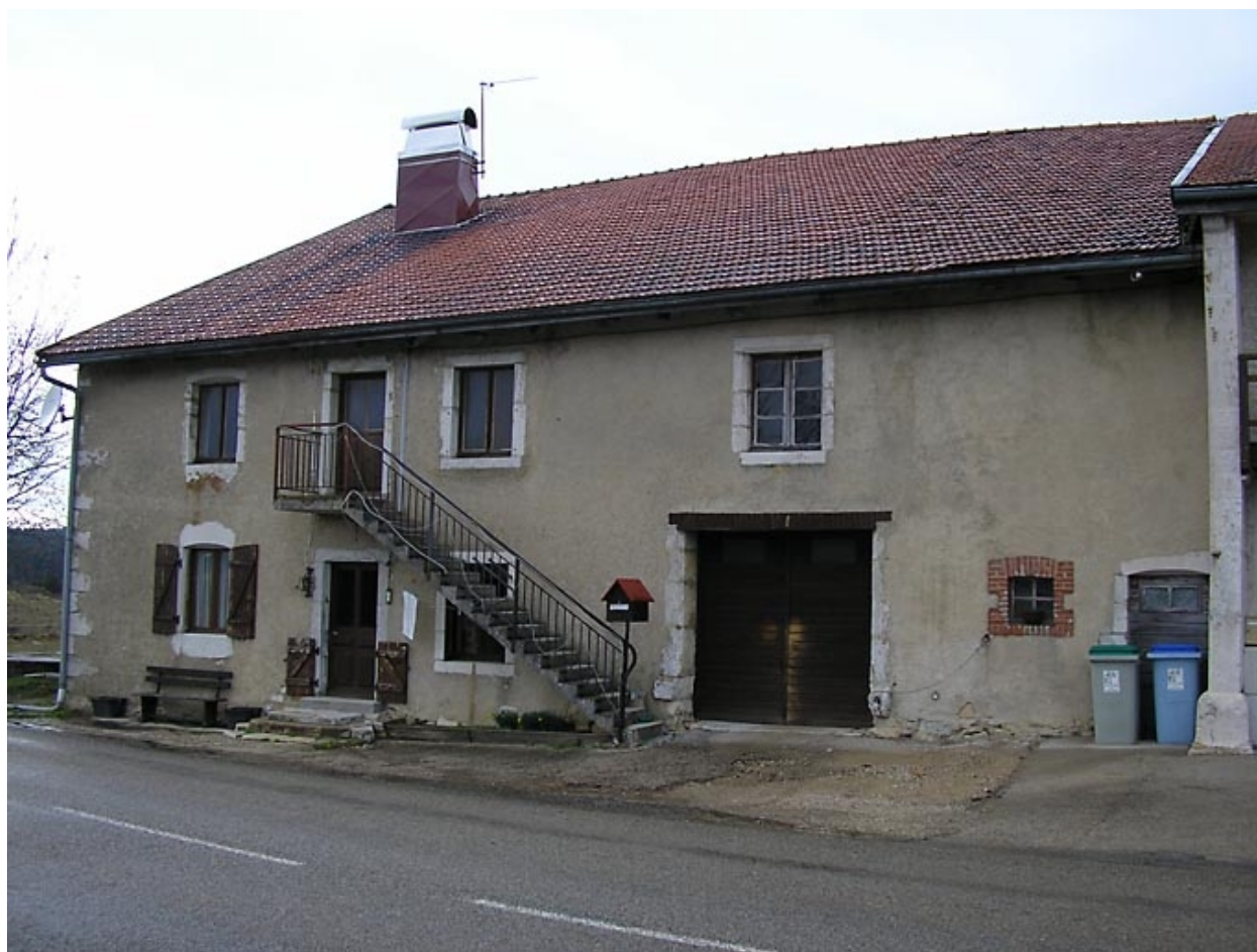
Ferme située au lieu-dit Les Brenets.
