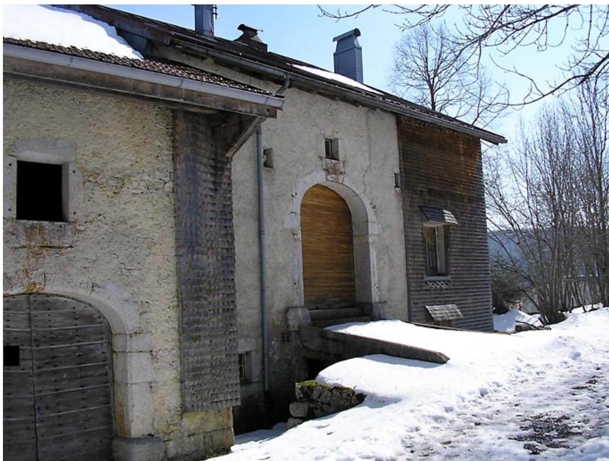
Ferme située au lieu-dit Les Jeannez.
