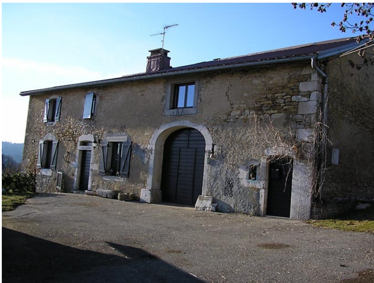
Ferme située au lieu-dit Les Brenets.
