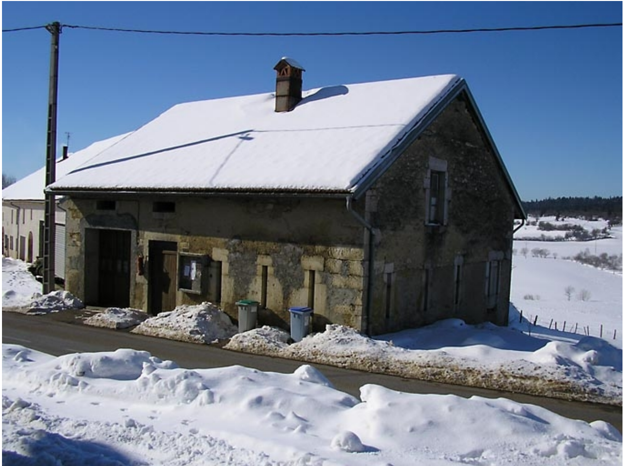
Fromagerie située au lieu-dit Les Bez.
