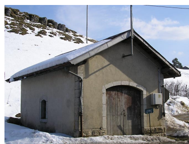
Remise de matériel incendie située au lieu-dit Les Chauvins. Phot. Marie-Pierre Reynet
