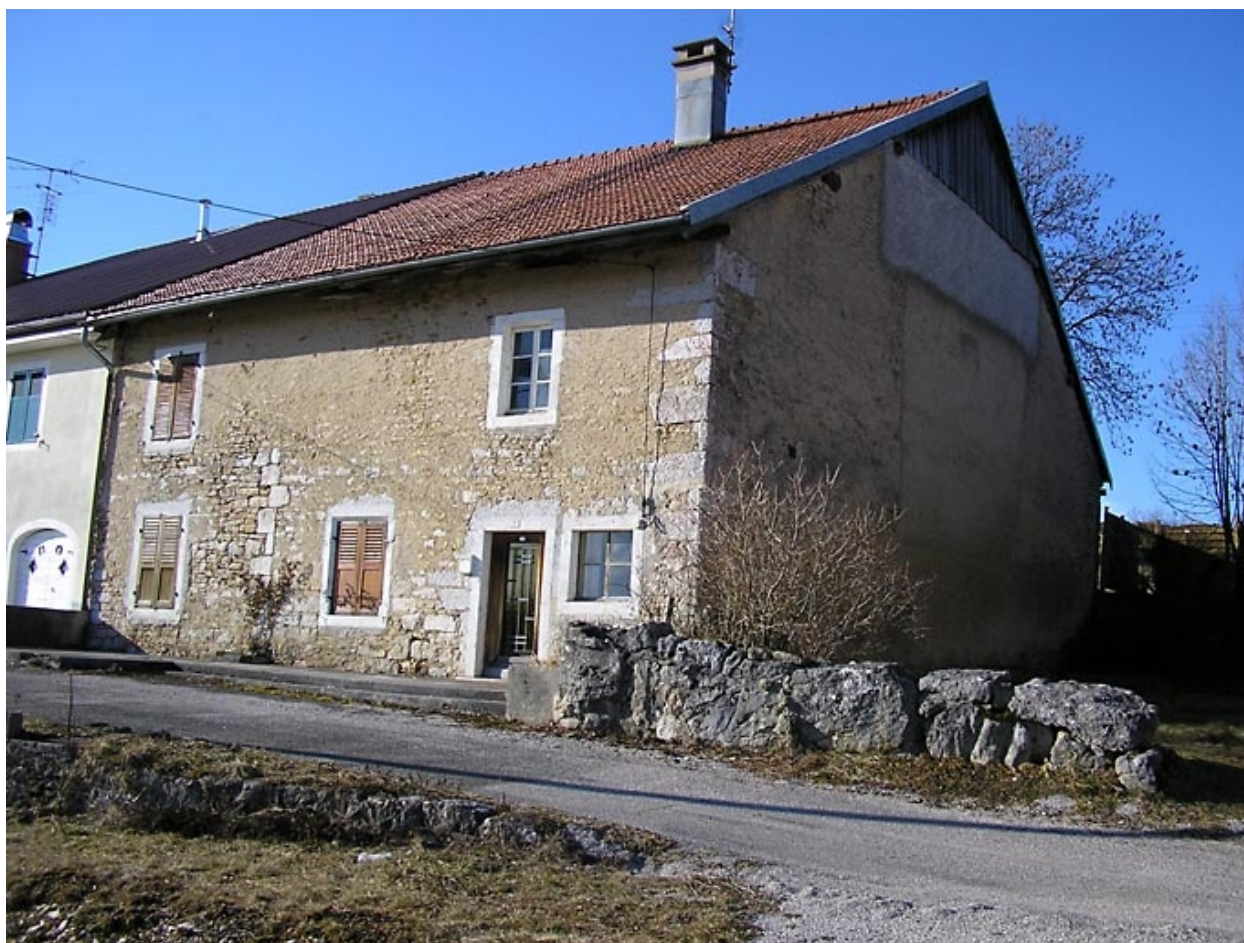
Ferme située au lieu-dit Les Faivre.
