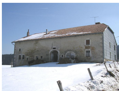
Ferme située au lieu-dit Les Mussillons. Phot. Marie-Pierre Reynet IVR43_20083900248NUC1A
