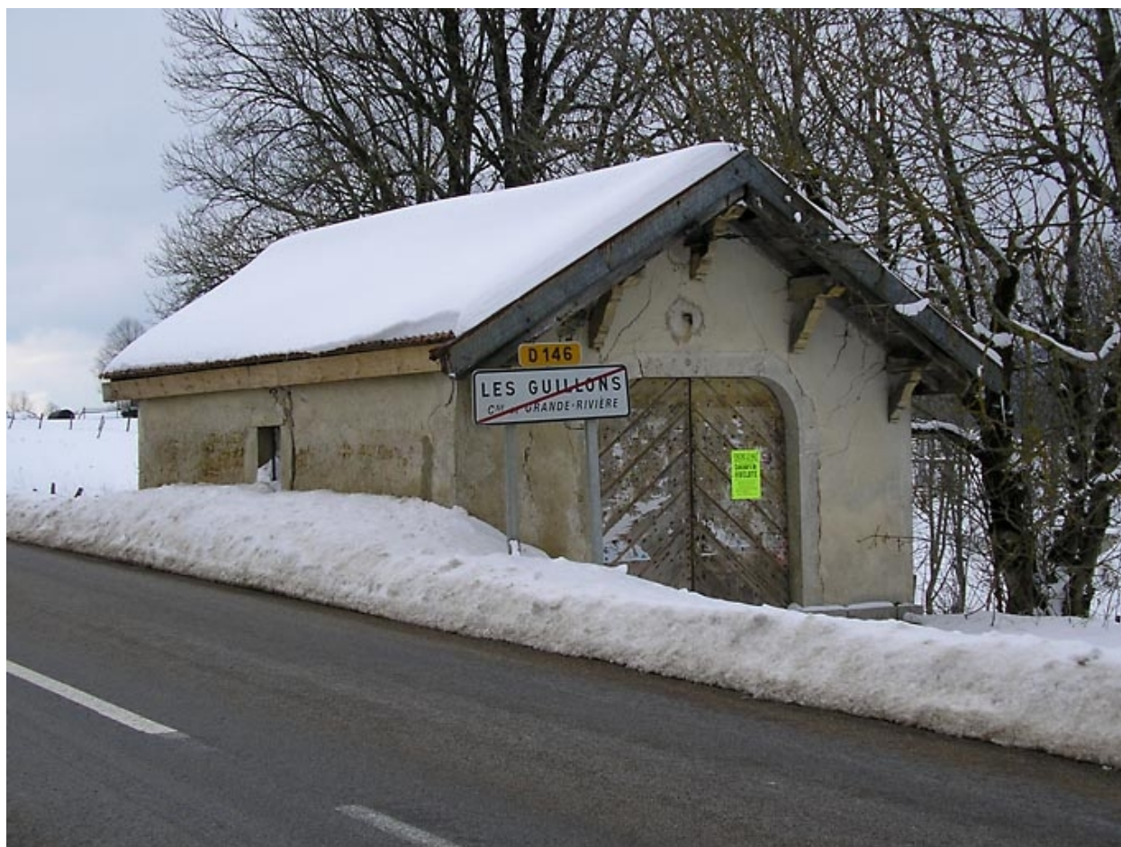
Remise de matériel incendie située au lieu-dit Les Guillons.
