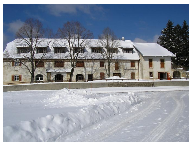
Etablissement conventuel, puis colonie de vacances des Perrets, actuellement maison, situé au lieu-dit Les Perrets. Phot. Marie-Pierre Reynet IVR43_20083900205NUC1A
