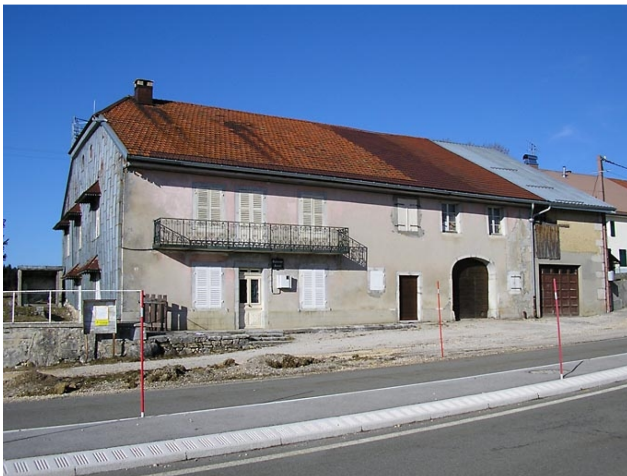
Ferme située au lieu-dit Les Faivre.
