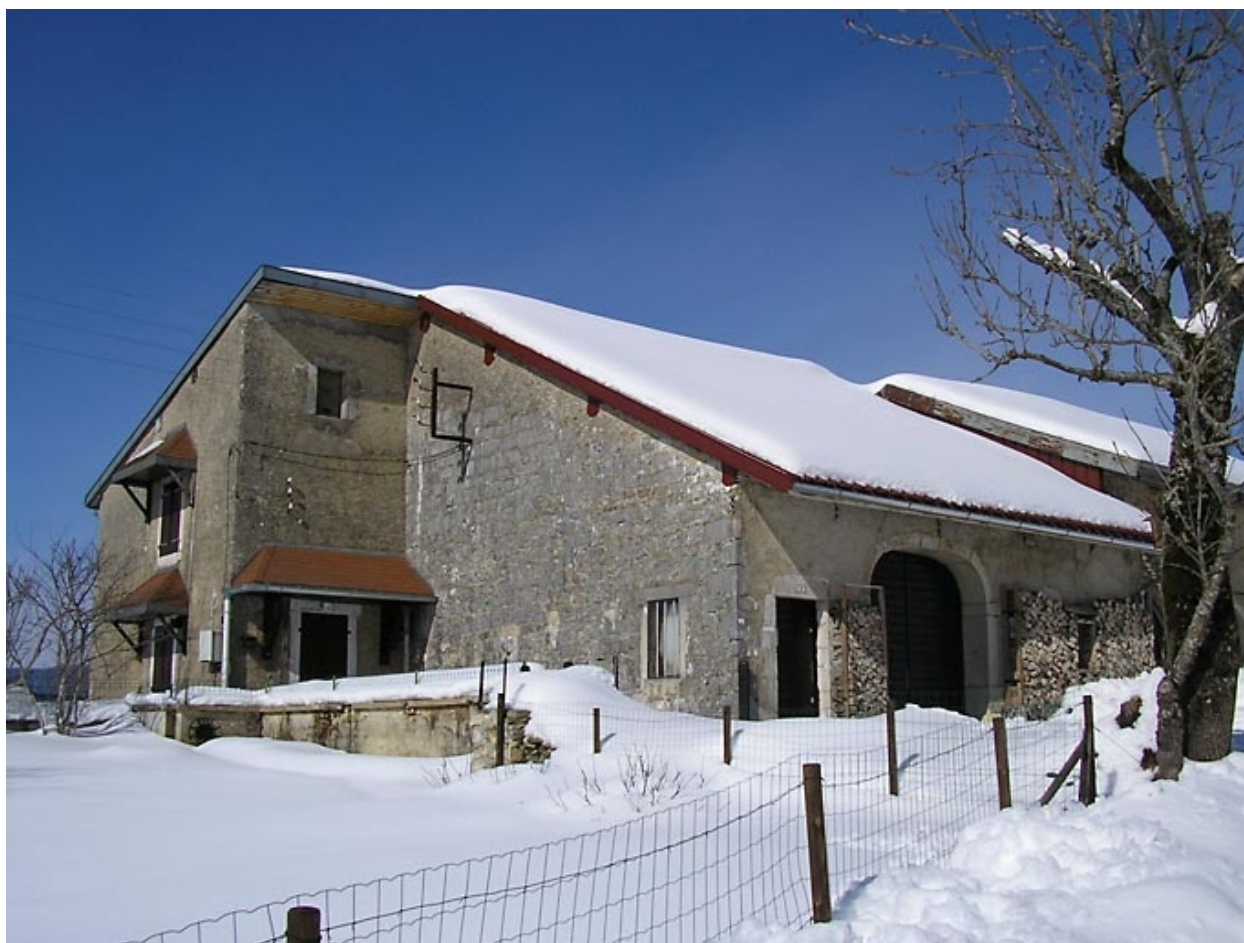
Ferme située au lieu-dit Sur le Moulin.
