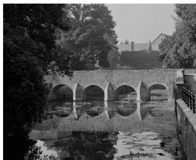
Vue d'ensemble prise en aval Phot. Jean-Luc Duthu IVR26_19922102666X
