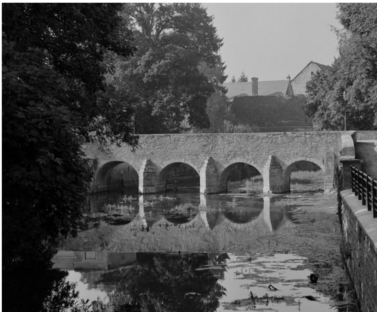
Vue d'ensemble prise en aval
