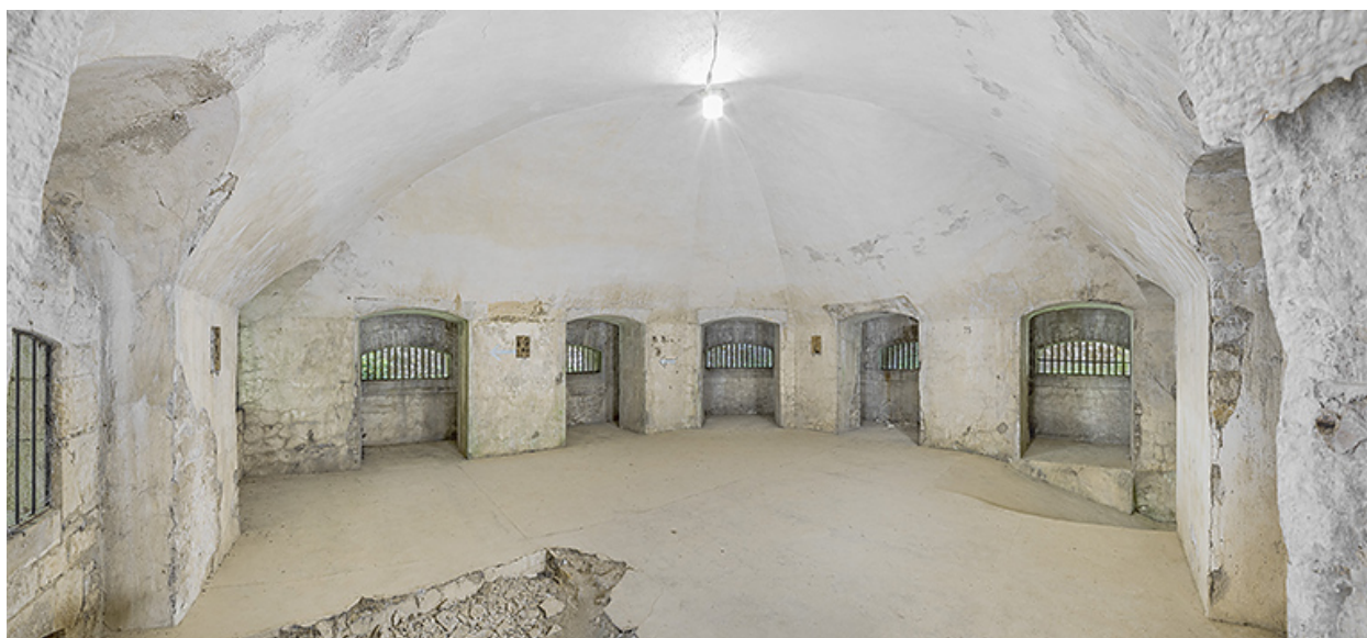
Le fort d'Hauteville : la double caponnière et ses ouvertures de tir.
