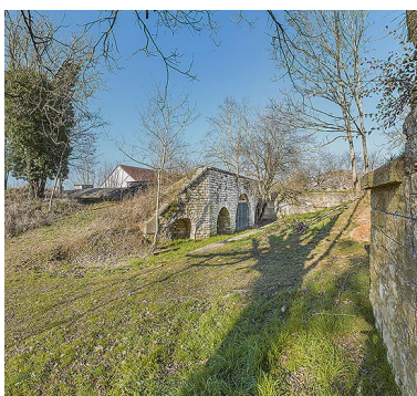
Le fort d'Asnières : batterie annexe de Norges. Phot. Thierry Kuntz IVR26_20252100063NUC4A
