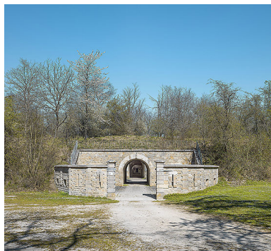
La redoute de Saint-Apollinaire : entrée de l'édifice (front de gorge).
