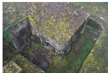
Le fort d'Hauteville : double caponnière (front d'attaque). (vue aérienne). Phot. Nicolas Douriaux IVR26_20262100355NUC4A
