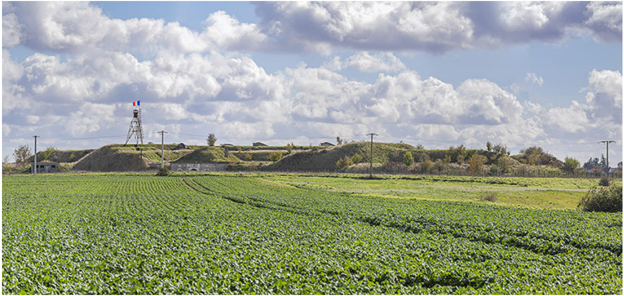
Le fort de Beauregard : vue depuis le nord-ouest.
