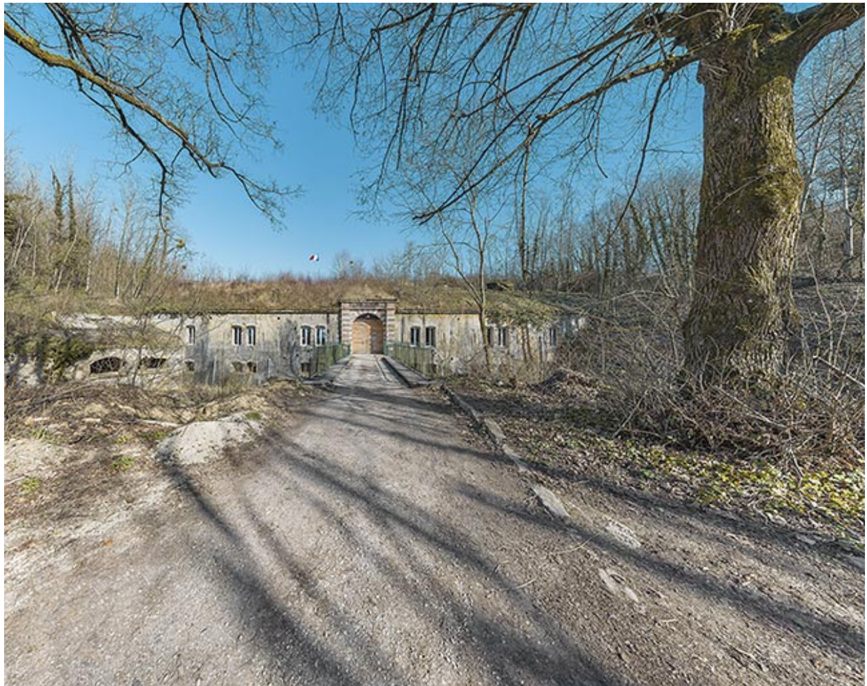
Le fort de Varois : front de gorge.
