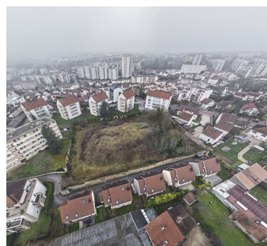
Poudrière, rue d'Auxonne. (vue aérienne). Phot. Nicolas Douriaux IVR26_20262100321NUC4A
