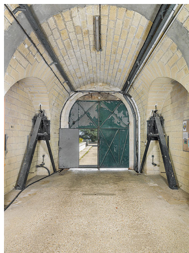
Le fort d'Hauteville : galerie d'entrée.
