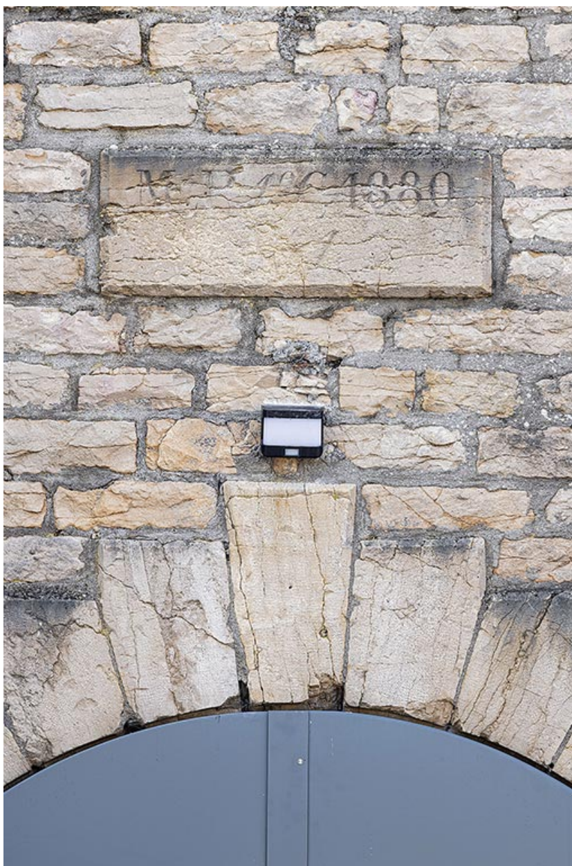
Site de l'ancien arsenal : magasin à poudre V1, date portée.
