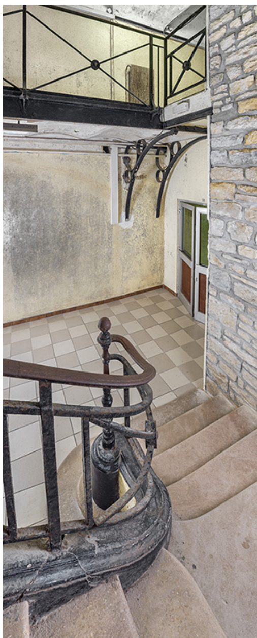
Le fort d'Hauteville : escalier distribuant le rez-de-chaussée et le premier étage du casernement.
