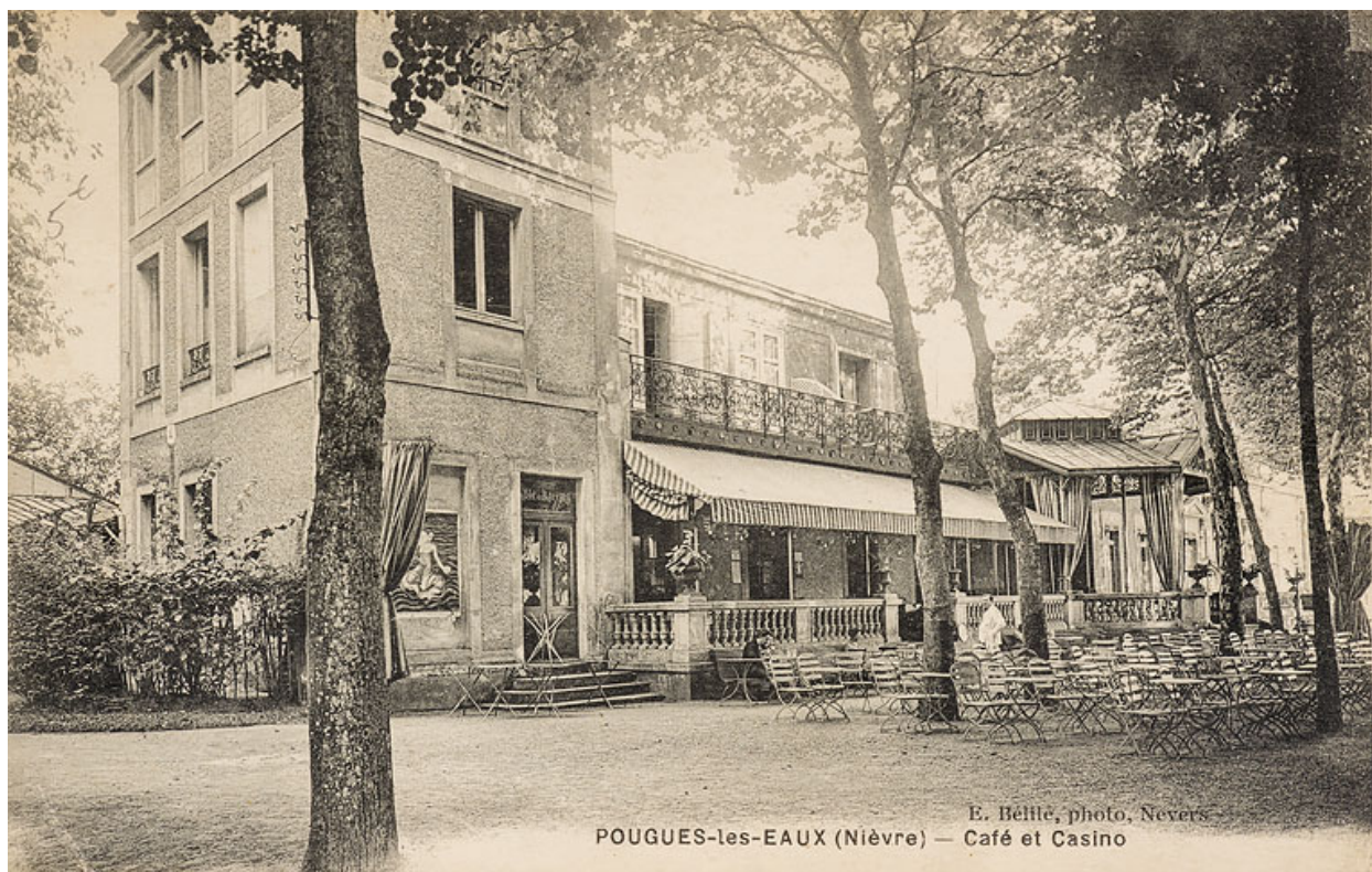
Bâtiment du cercle, vue extérieure.
