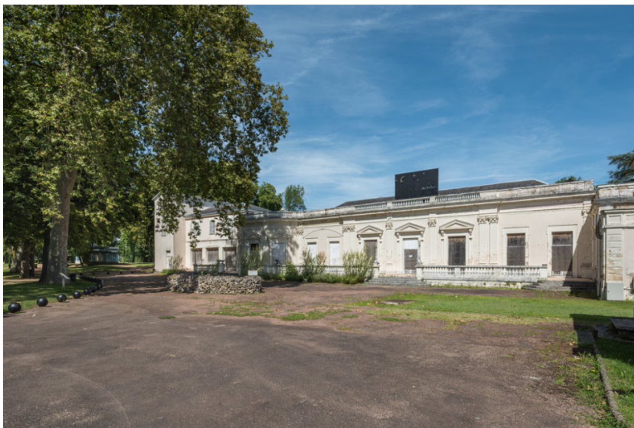
Façade, vue depuis le sud-ouest.
