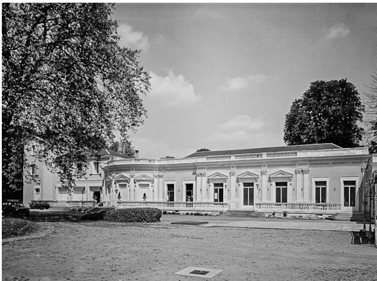
Façade, vue depuis le sud-ouest.
