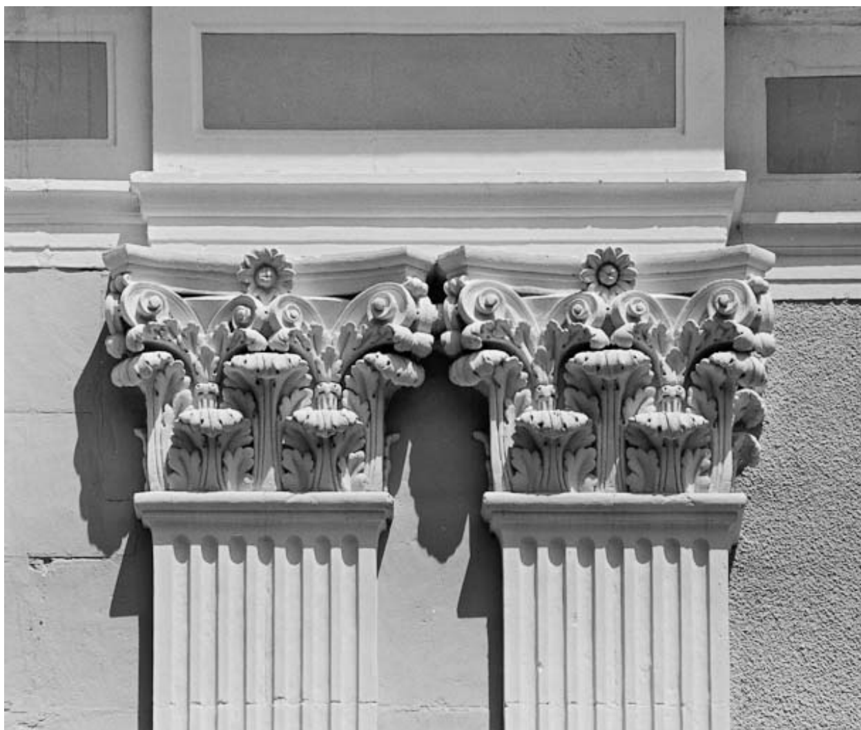
Façade, chapiteaux des pilastres jumelés.
