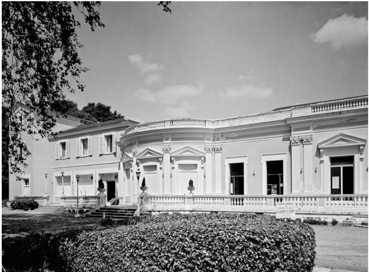
Façade, vue depuis le sud-ouest.
