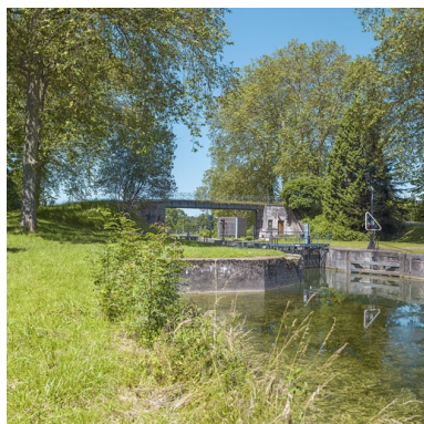
Vue d'ensemble du pont, depuis l'aval.
