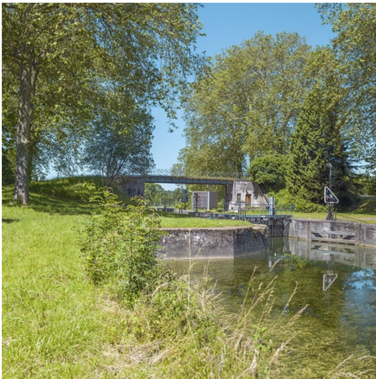
Vue d'ensemble du pont, depuis l'aval.
