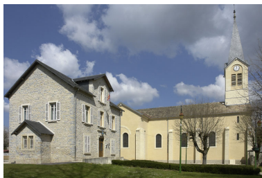
Elévation latérale gauche, vue d'ensemble avec au premier plan, l'ancien presbytère actuellement mairie. Phot. Alain Morelière IVR26_20082105354NUC2A
