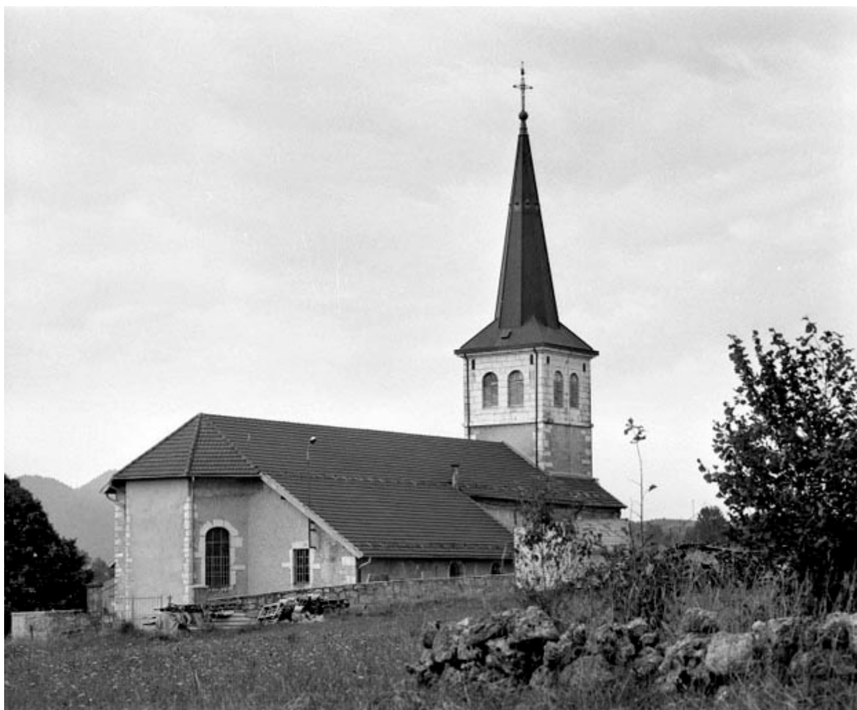
Extérieur : vue générale depuis le nord-est.
