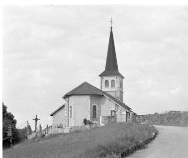
Extérieur : l'abside. Phot. Yves Sancey IVR43_19943900992X
