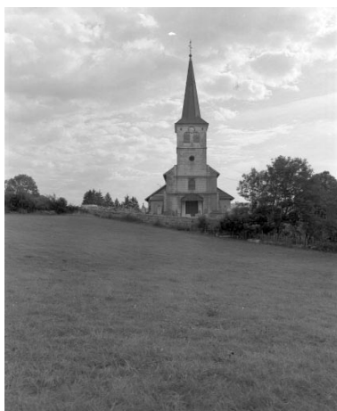
Vue de situation depuis l'ouest. Phot. Yves Sancey IVR43_19943900994X
