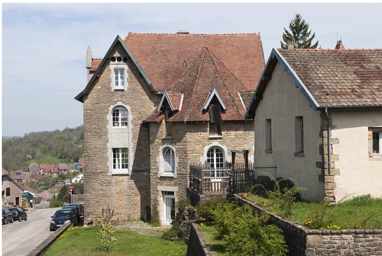
Bâtiment (G), côté rue.
