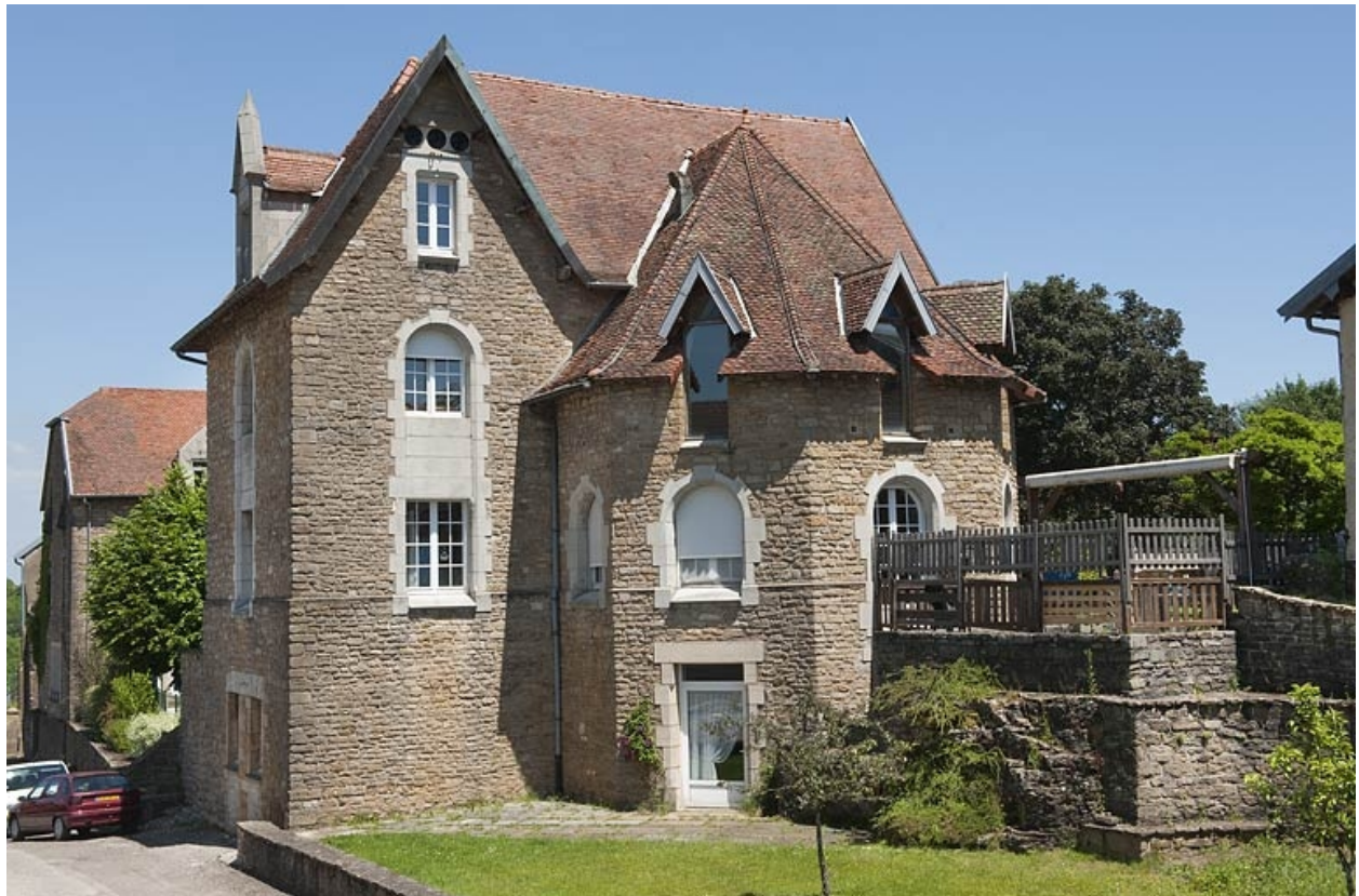
Bâtiment (G), vue rapprochée.
