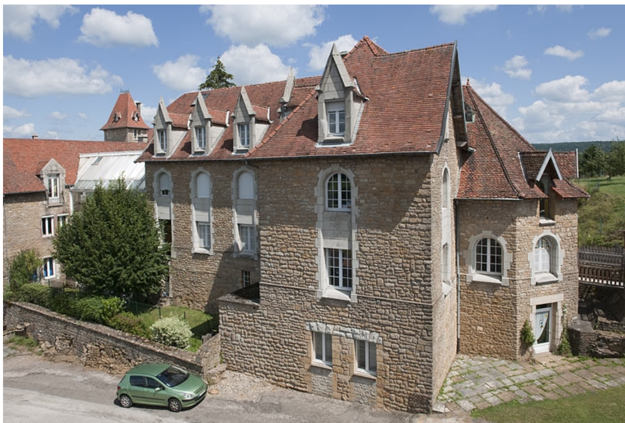
Bâtiment (G), vue d'ensemble côté rue.
