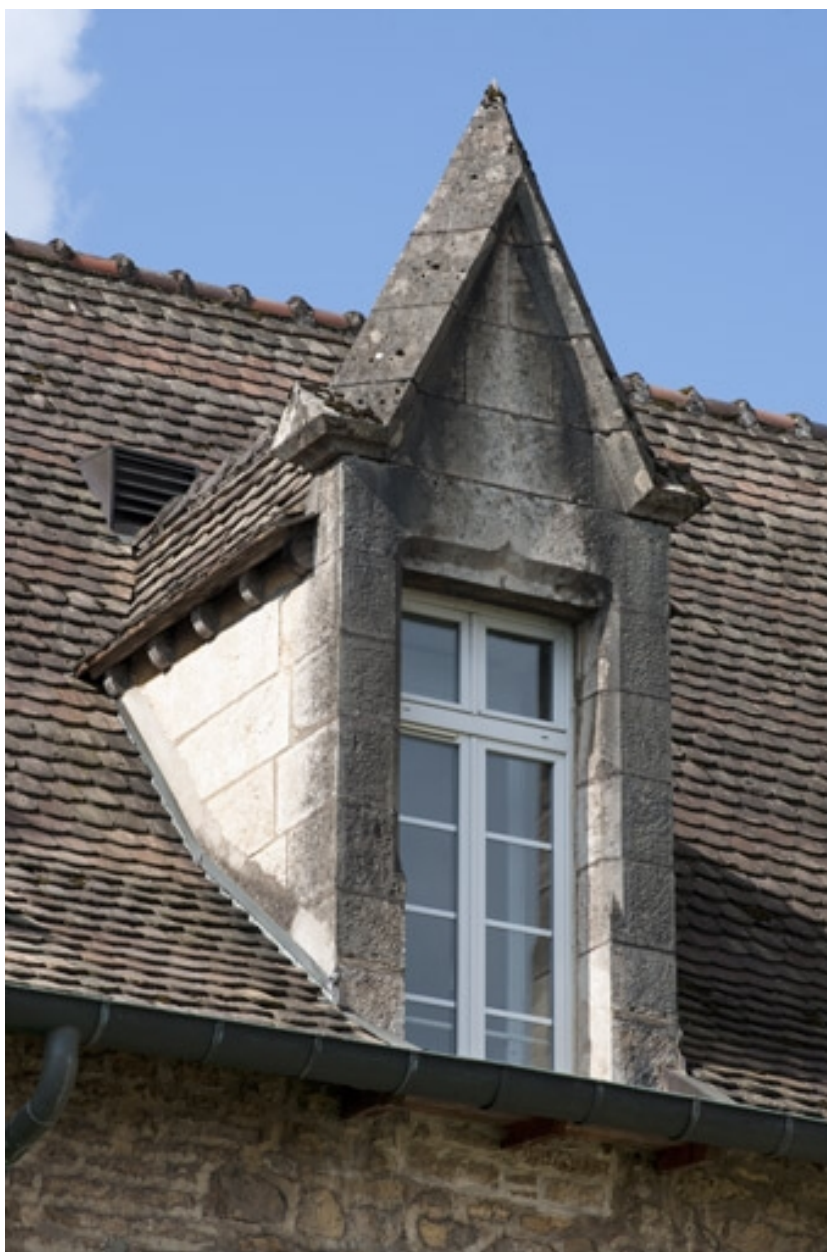
Bâtiment (C), côté jardin, détail d'une lucarne.
