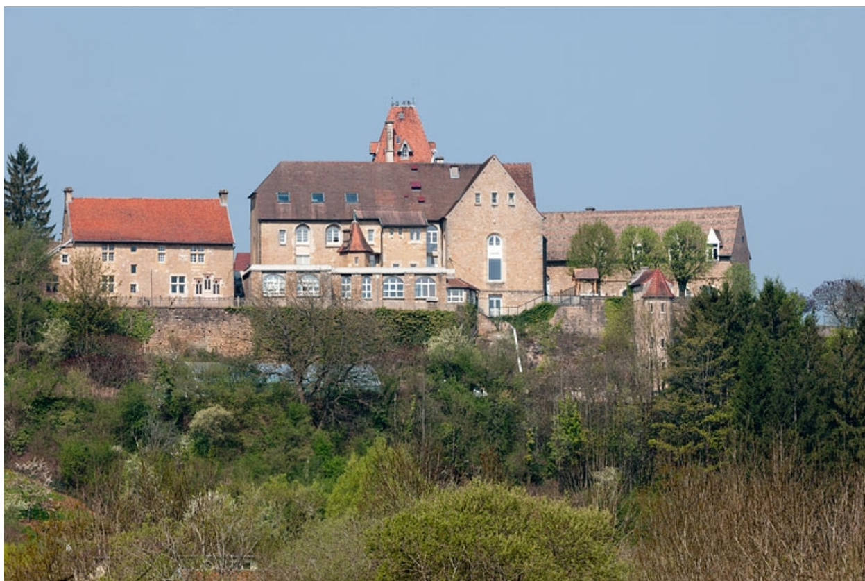
Vue générale depuis la route de Gouhelans.
