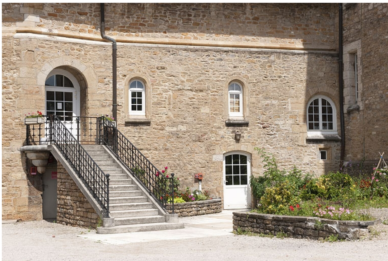
Bâtiment (C), escalier côté cour.
