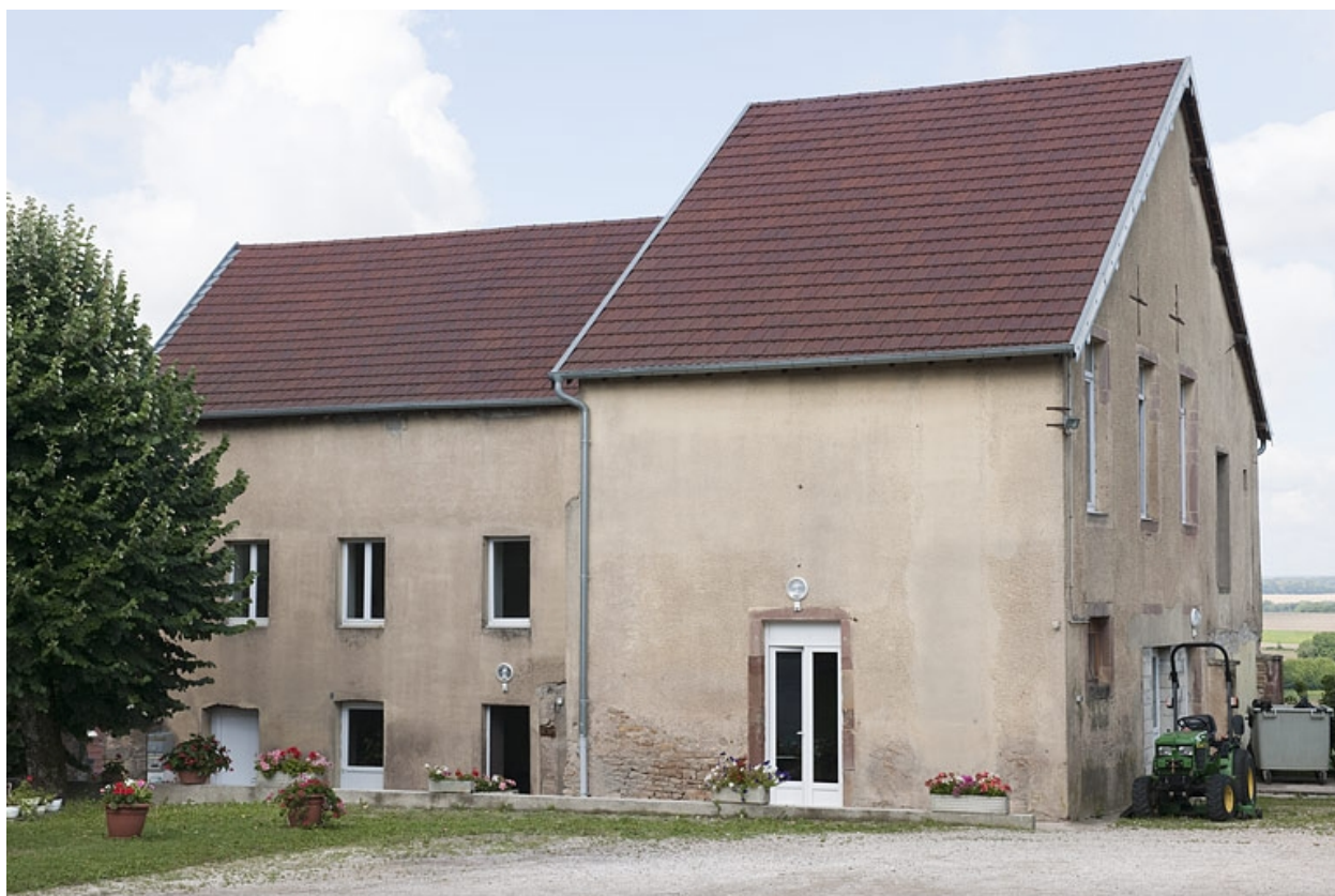
Bâtiment (B), vue d'ensemble depuis la cour.
