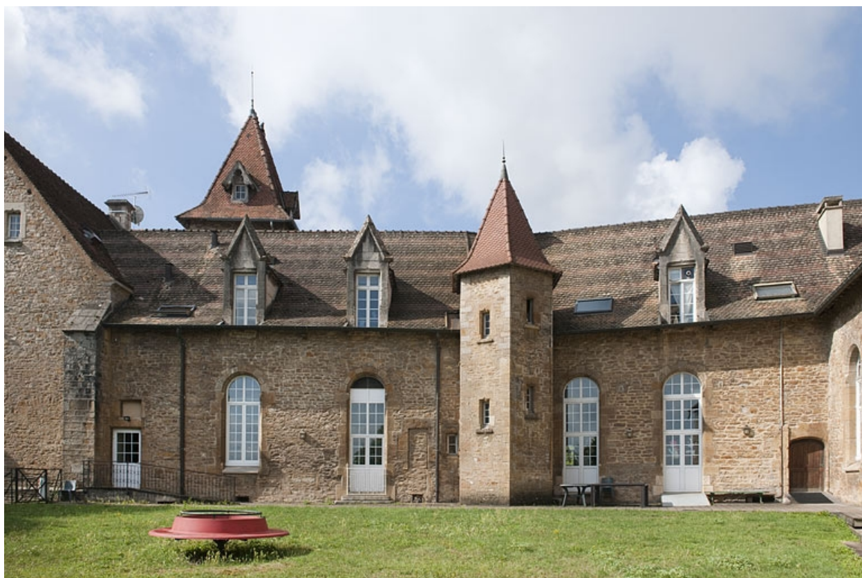
Bâtiment (C), vue d'ensemble côté jardin.
