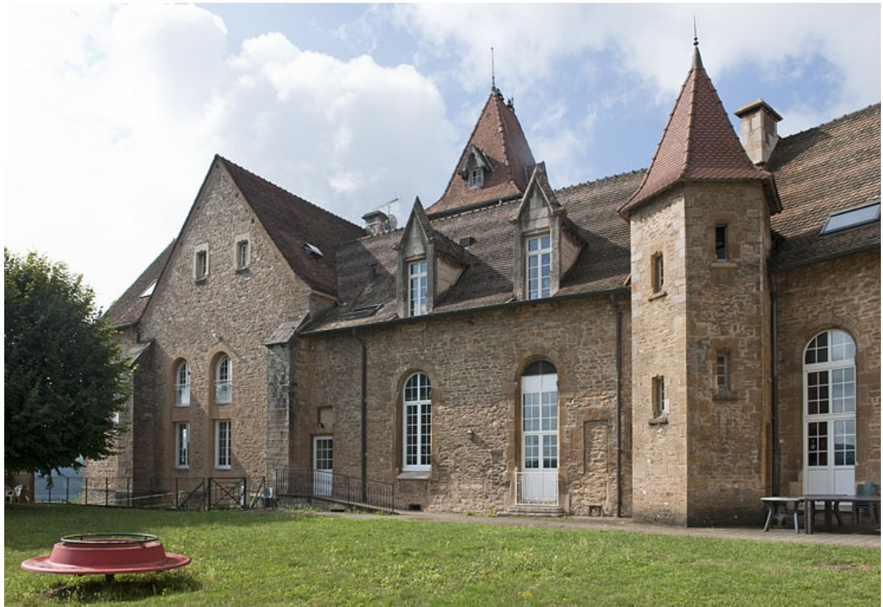
Bâtiment (C), côté jardin.
