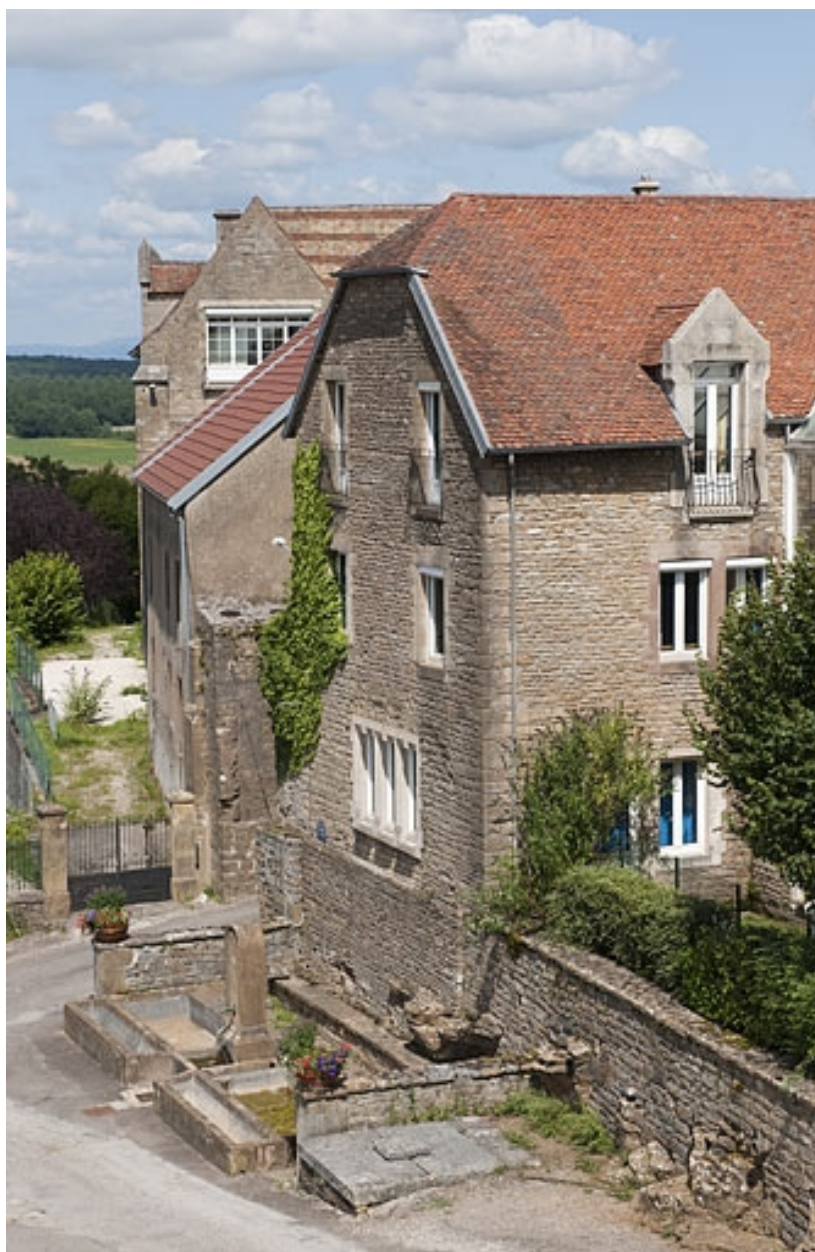
Bâtiment (A), vue rapprochée du côté rue.
