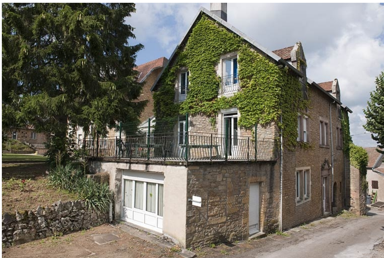
Bâtiment (A), vue de trois quart gauche.
