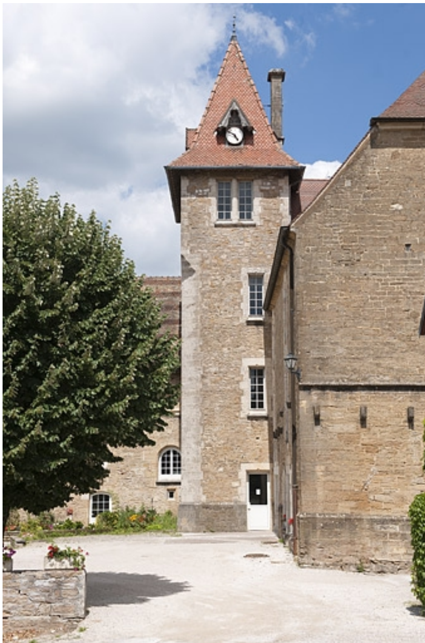
Bâtiment (C), vue de la tour d'escalier.
