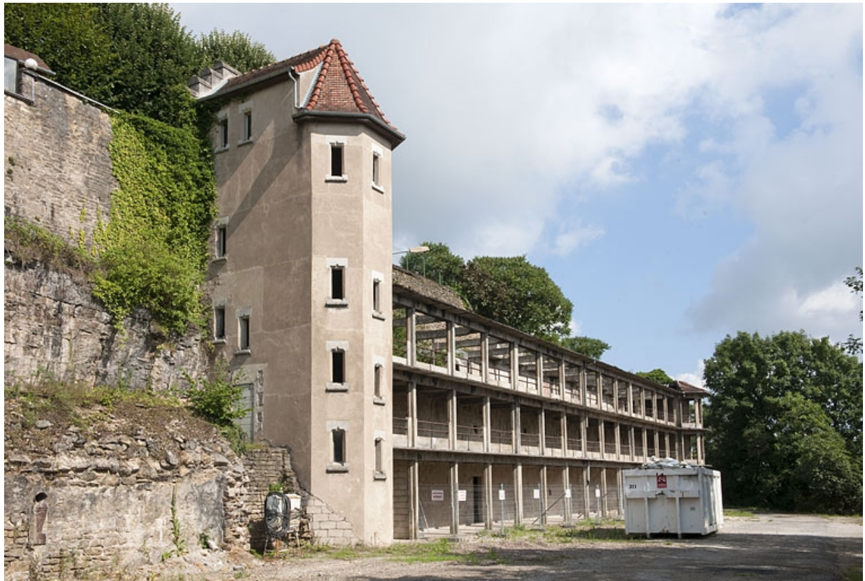
Bâtiment (H), vue rapprochée de la galerie.
