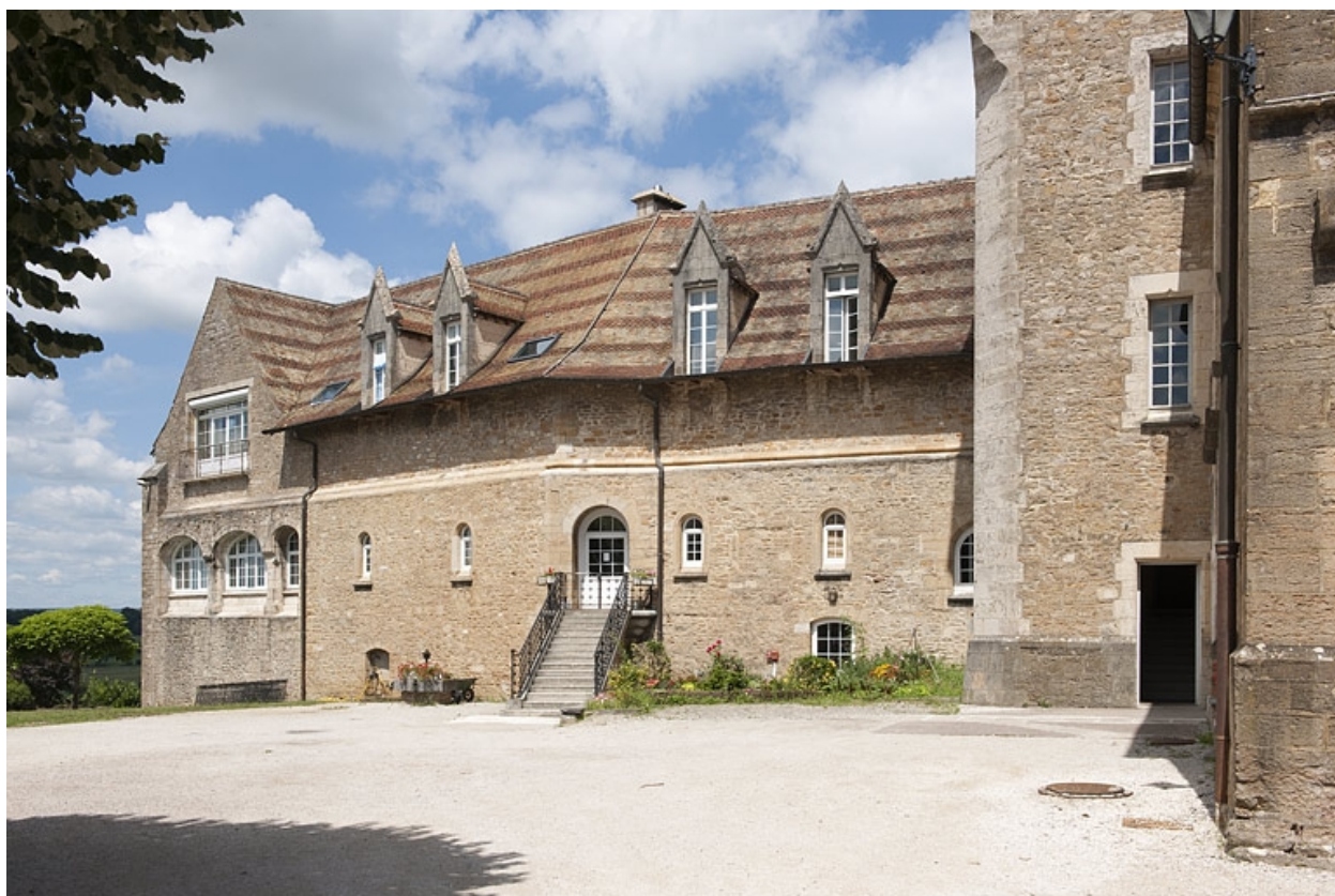
Bâtiment (C), vue depuis la cour.
