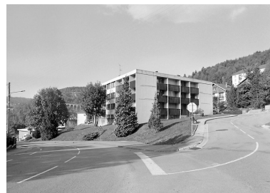
Ancien centre commercial, 25 avenue de la Libération. Phot. Yves Sancey IVR43_20033900915X
