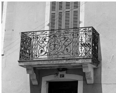
Détail : balcon en ferronnerie d'une baie du premier étage. Phot. Yves Sancey IVR43_19897000335X
