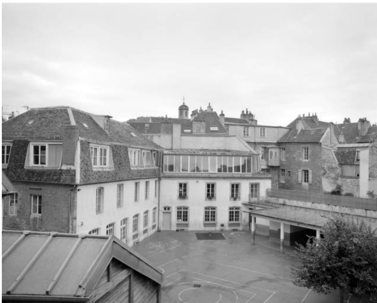
Vue d'ensemble de la deuxième cour.
