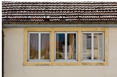
Bureau : fenêtres multiples sur la façade antérieure. Phot. Sonia Dourlot IVR43_20162501289NUC4A
