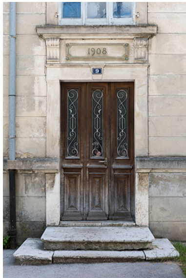
Maison : porte sur la façade antérieure. Phot. Sonia Dourlot IVR43_20162500825NUC4A
