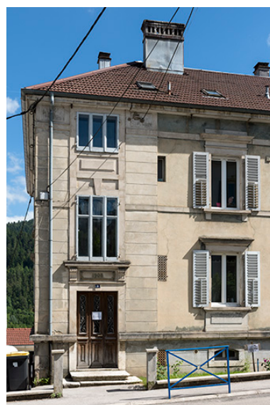
Maison : travée d'entrée sur la façade antérieure. Phot. Sonia Dourlot IVR43_20162500824NUC4A
