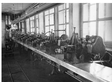
Atelier de taillage (machines à tailler par génération), vers 1950. IVR43_20182500831NUC4A
