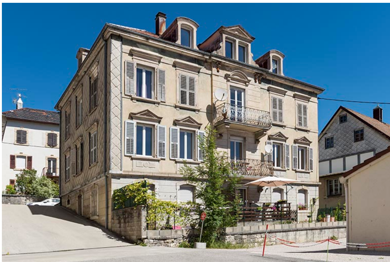
Maison : façades postérieure et latérale droite.
