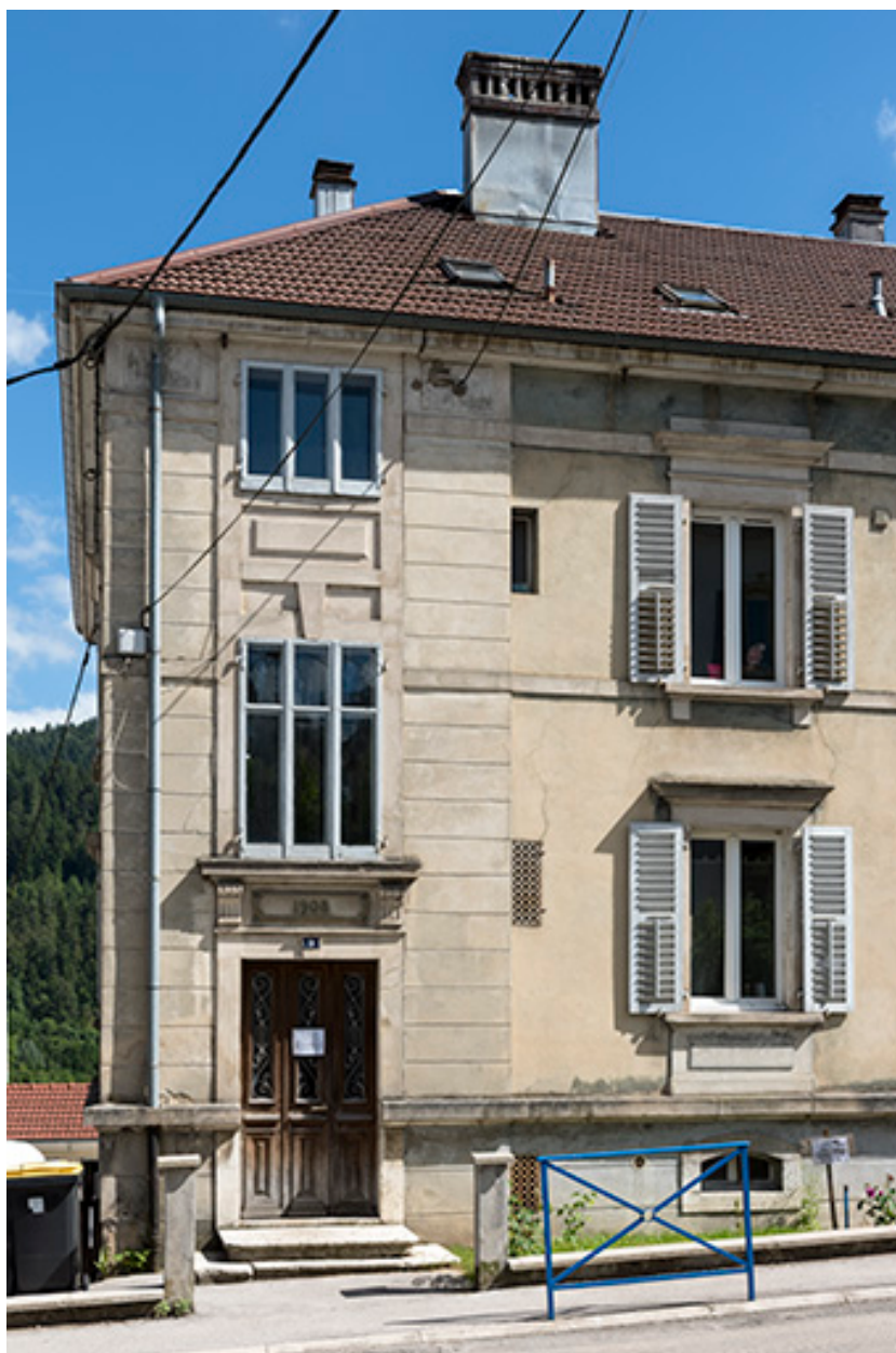
Maison : travée d'entrée sur la façade antérieure.
