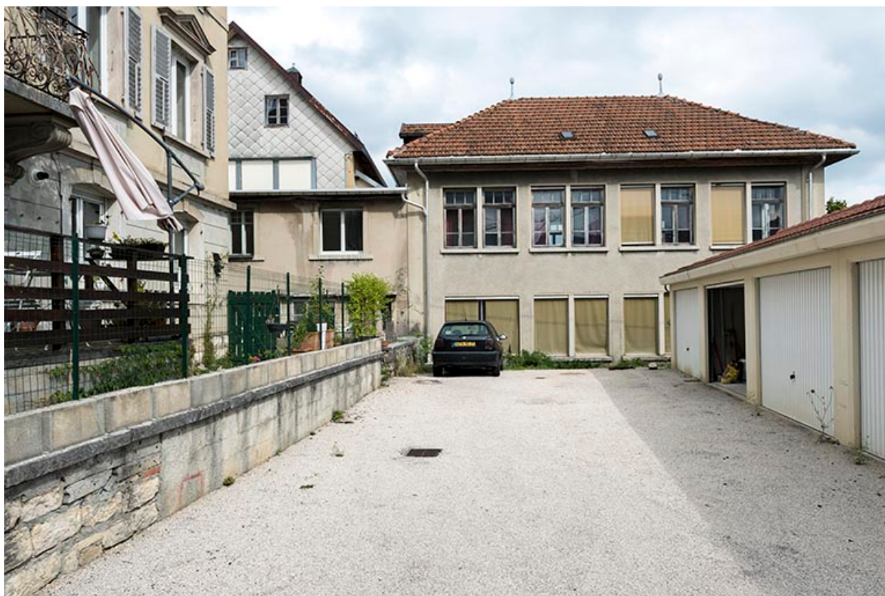
Usine : atelier de mécanique (façade latérale droite).
