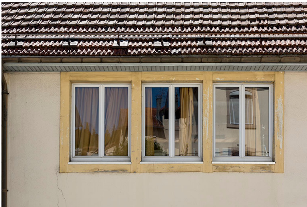
Bureau : fenêtres multiples sur la façade antérieure.
