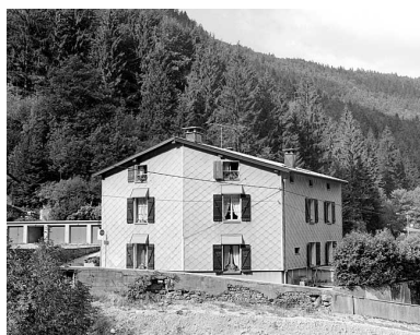
Elévations postérieure et latérale droite. Phot. Yves Sancey IVR43_20033900336X
