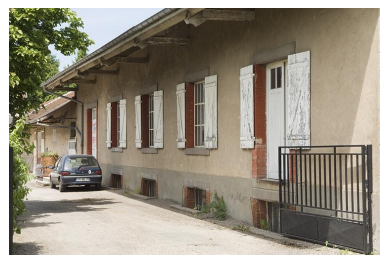
Façade du chai, à l'entrée. Phot. Jérôme Mongreville IVR43_20097000326NUC2A
