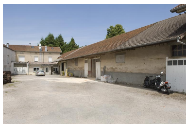
Logement et cuverie. Phot. Jérôme Mongreville IVR43_20097000327NUC2A
