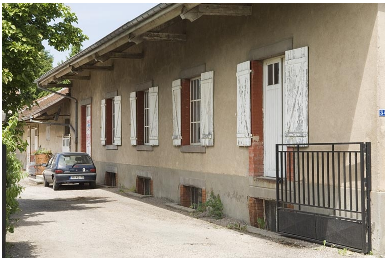
Façade du chai, à l'entrée.
