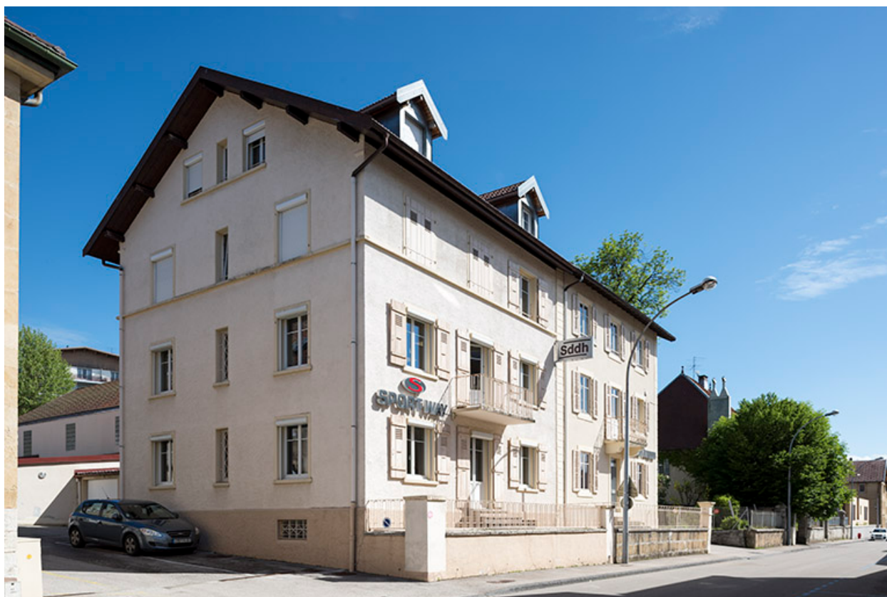
Façades antérieure et latérale gauche.
