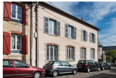
Façade sur rue. Phot. Jérôme Mongreville IVR43_20182500539NUC4A
