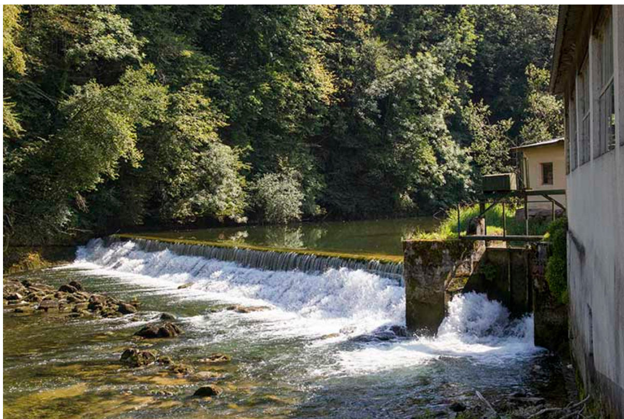
Le barrage et la vanne de décharge.
