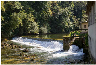
Le barrage et la vanne de décharge. Phot. Yves Sancey IVR43_20132501537NUC2A
