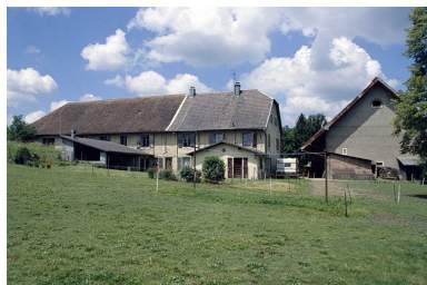
Façade postérieure. Phot. Yves Sancey IVR43_20009000431ZA
