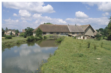
Canal d'amenée du moulin. Phot. Yves Sancey IVR43_20009000433ZA
