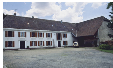
Façade antérieure. De gauche à droite : logement, moulin et parties agricoles. Phot. Yves Sancey
