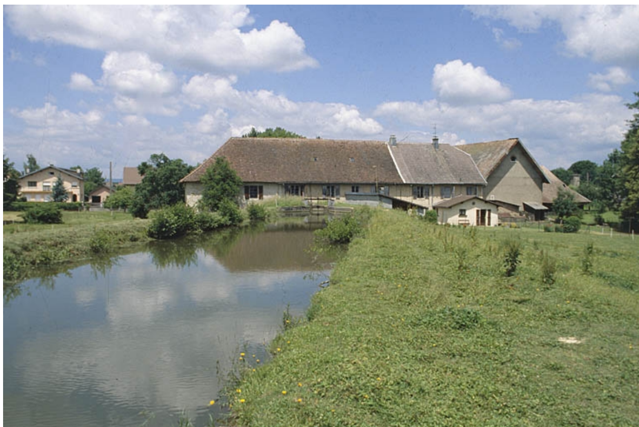
Canal d'amenée du moulin.
