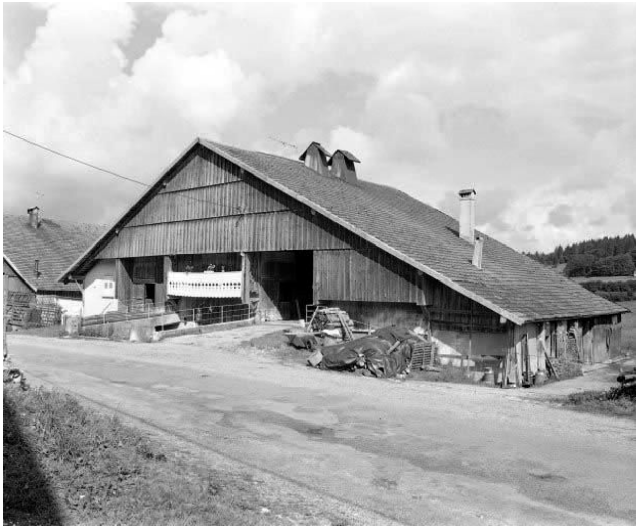
Façades antérieure et latérale droite.
