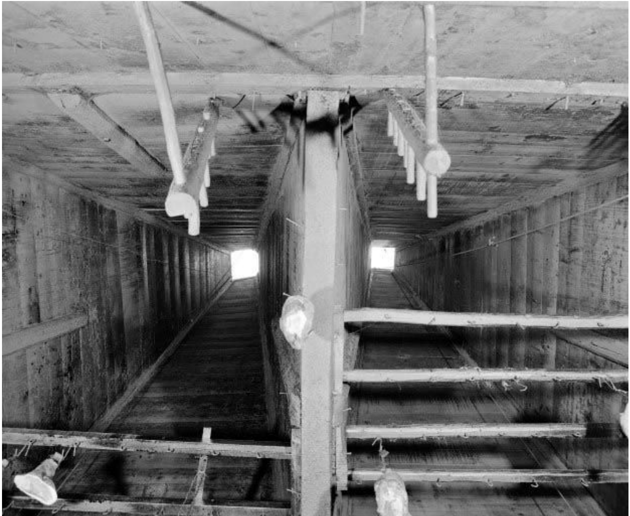
Intérieur : conduit des "tués"jumelés.
