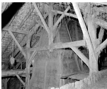
Charpente et conduits des "tués"jumelés, vus de trois quarts. Phot. Yves Sancey IVR43_19772500427X
